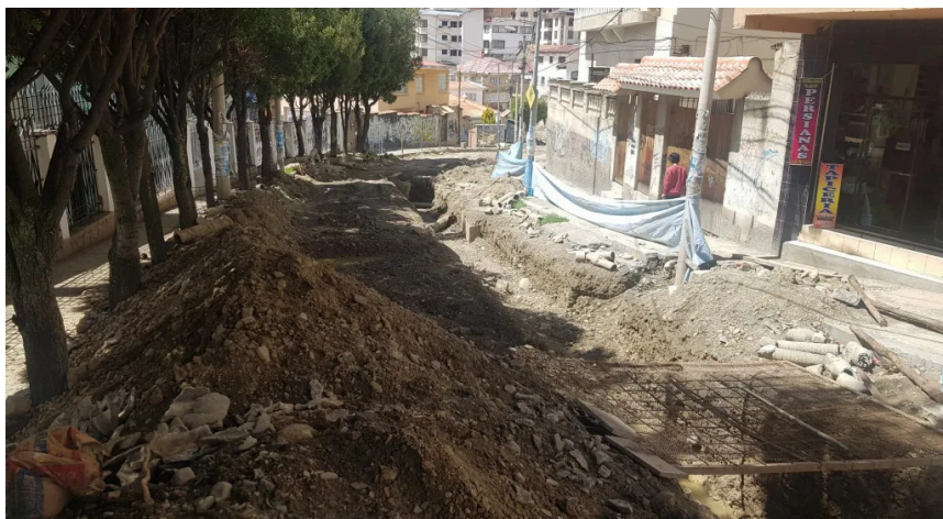
Trabajos en la Av. Abdón Saavedra en el Barrio de Sopocachi en La Paz, una vía importante de conexión, que fue cerrada para realizar los trabajos, en octubre de 2024 se anunció su entrega para el 31 de enero de 2025, hasta la fecha no se ha concluido, se mantiene cerrada, generando, además, la desconexión de por lo menos cuatro vías importantes a ambos lados de su trazo. Imagen y datos: Periódico La Razón, 01 de febrero de 2025.
