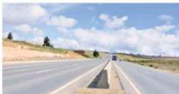
Carretera doble vía Oruro - La Paz
