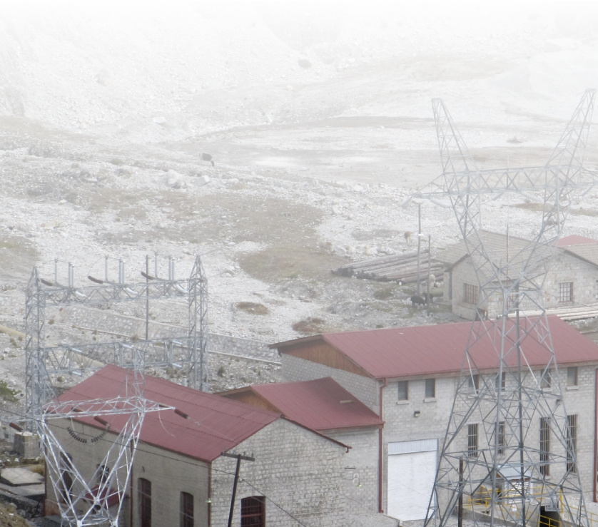
Planta Generadora Cahua Fuente: Archivo Fotográfico GAMLP
