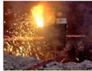
Paso 7, reacción exotérmica dentro el molde
