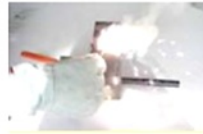
Paso 7, reacción exotérmica dentro el molde
