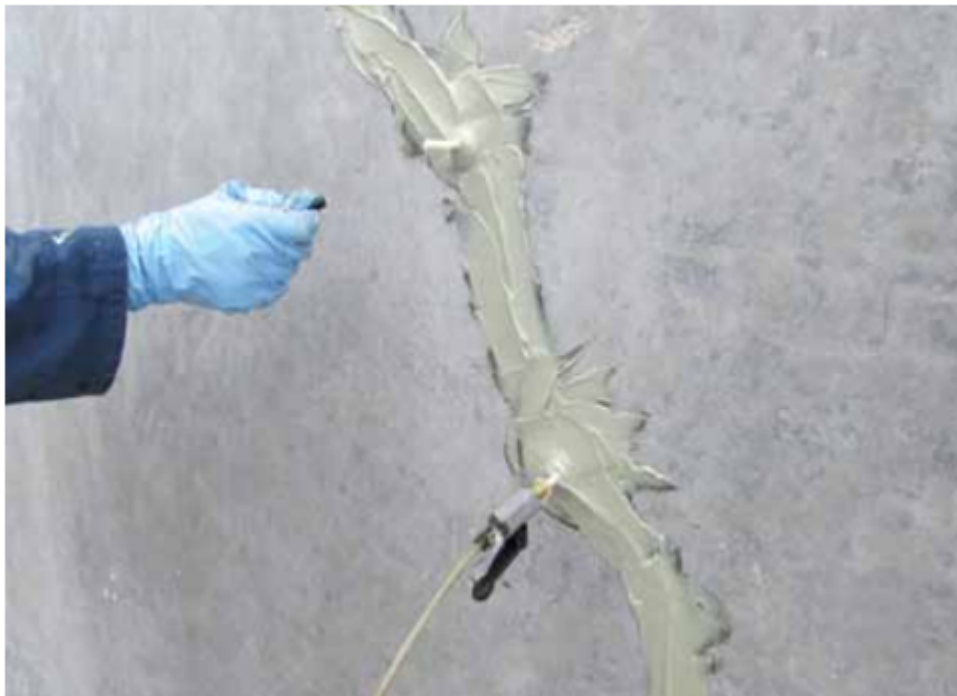
SELLADO DE FISURAS EN CARAS VERTICALES
