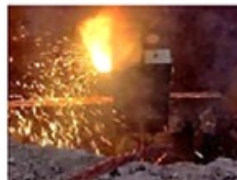
Paso 7, reacción exotérmica dentro el molde
