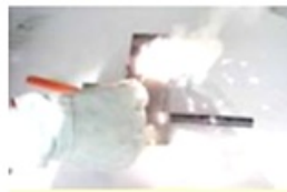
Paso 7, reacción exotérmica dentro el molde
