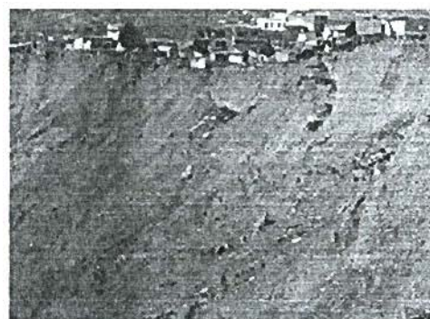
Fotografía 7 – Talud de Gravas Pampahasi
