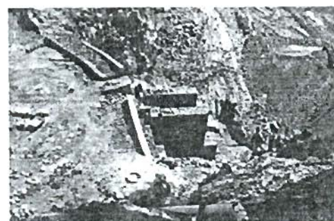
Fotografía 4 – Muro y rápida de gaviones
