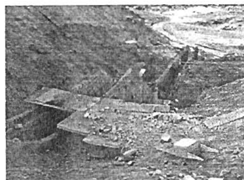
Fotografía 5 – Canalización de Ho. armado
