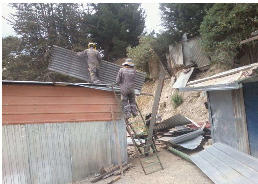
En la foto: Personal del Programa se encuentra construyendo su “Pahuichi” (vestidor) ubicado en la Avenida Zabaleta.
