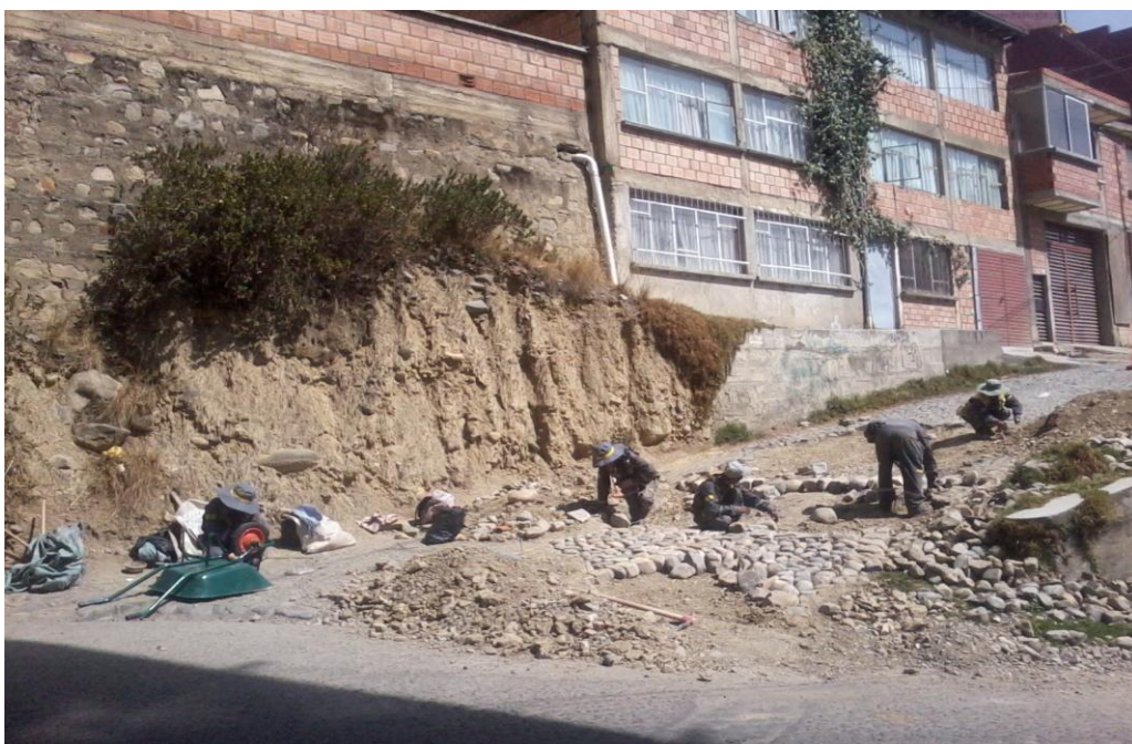
En la foto: Cuadrilla del Programa realizando el bacheo en la Avenida Zabaleta
