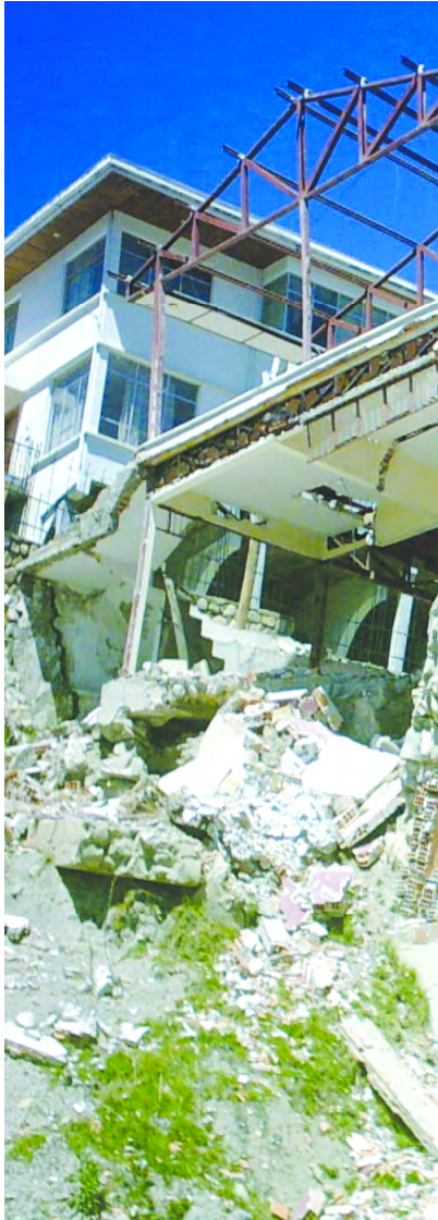
Deslizamiento de vivienda. Alto Seguencoma
