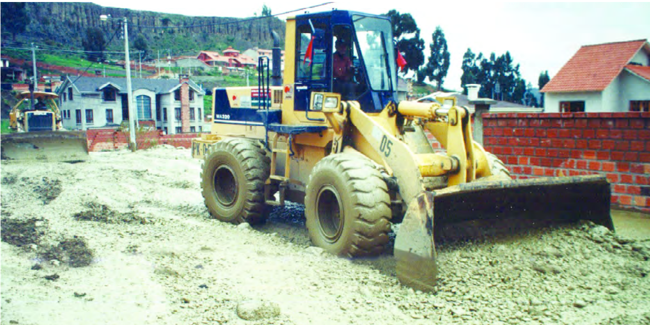
Trabajos de reparación a causa de los desbordes de ríos
