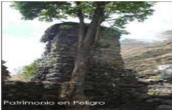
Imagen 2. Estructura con técnicas de construcción tradicional
