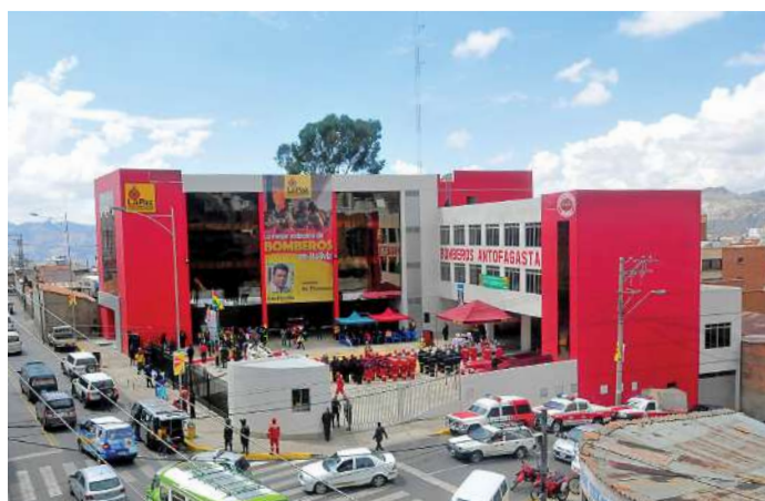
Fotografía N°40. Municipio de La Paz: Estación de Bomberos Antofagasta; Fuente: Archivo GAMLP
