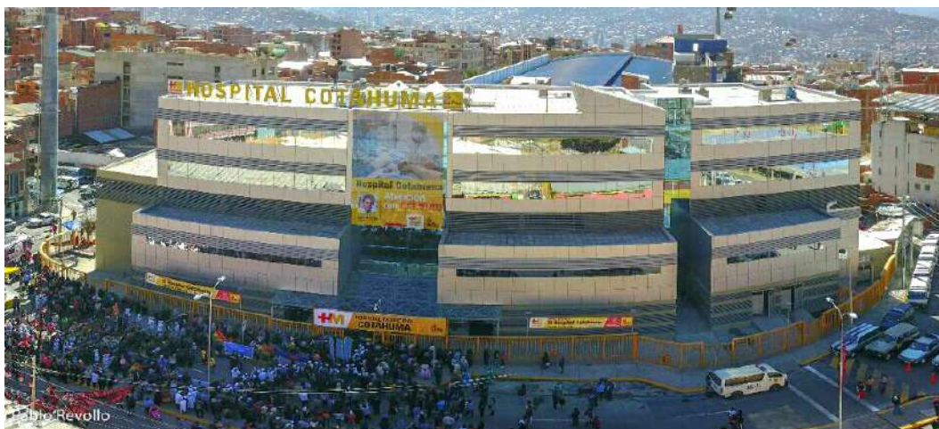
Fotografía N°65. Municipio de La Paz: Hospital Municipal Cotahuma; Fuente: Archivo GAMLP
