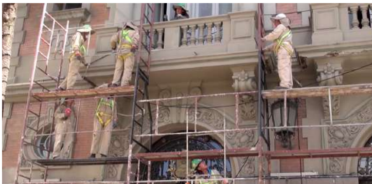
Fotografía N°57. Municipio de La Paz: Conservación de la fachada del Palacio Consistorial por la Escuela Taller; Fuente: Archivo GAMLP.
