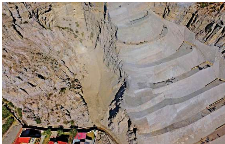
Fotografía N°34. Municipio de La Paz: Estabilización de área de deslizamiento; Fuente: Archivo GAMLP
