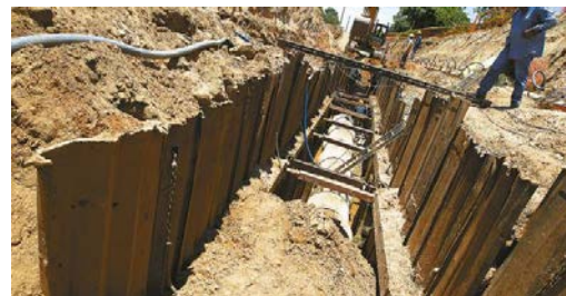
F69. Obra de alcantarillado en el Plan 3000, Santa Cruz 2014. Foto: Hernán Virgo, Periódico El Deber.
