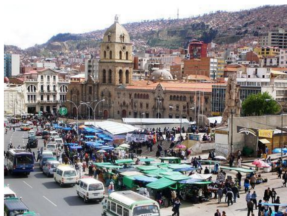
F51. GAMLP: Plaza San Francisco, ciudad de La Paz, antes de las intervenciones del Programa de Revitalización del Centro Histórico.
