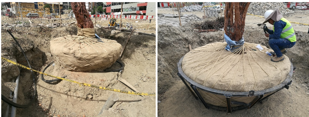
Fotografías 6 y 7. Formación de cepellón con yutes y armado de estructura de fierro para el izado.
