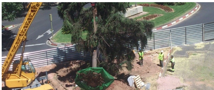
Fotografía 10. Árbol con cepellón levantado por grúa
