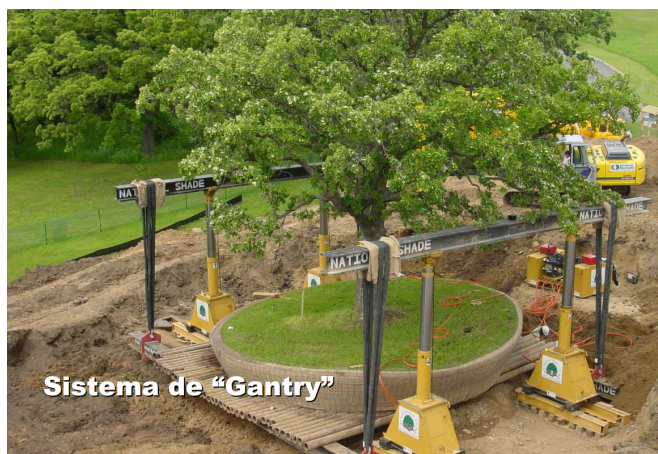
Fotografía 11. Árbol con cepellón levantado por grúa.
