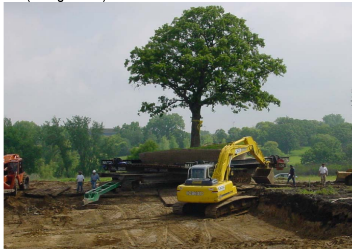
Fotografía 1. Excavación del lugar donde será trasplantado el árbol
