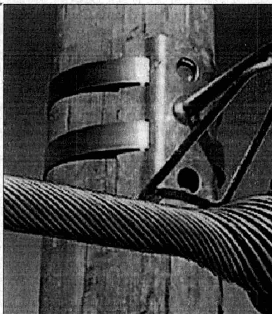
Figura 2 Forma de sujeción con Zunchos metálicos
