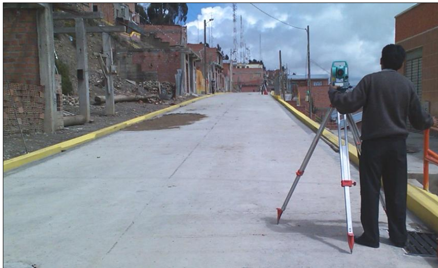
Fig. 43- Lectura de puntos de control entre brigadas
