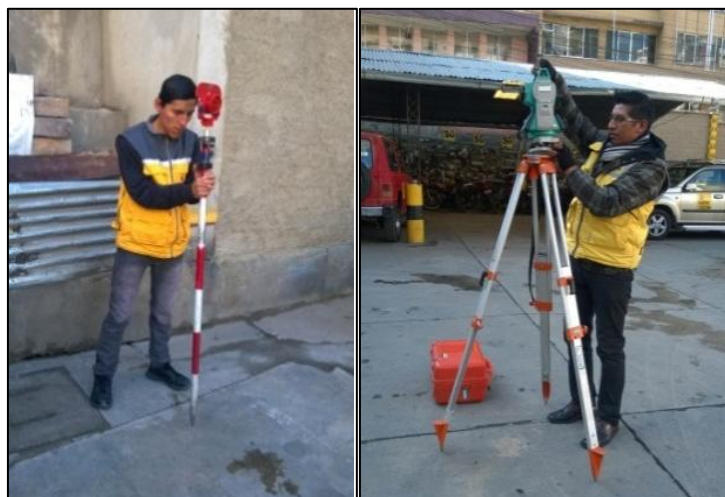
Paso 3: Nivelación del punto de control
