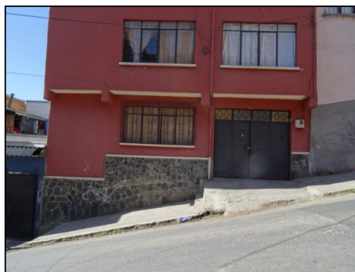
Fig. 13- Delimitación pared consolidada
