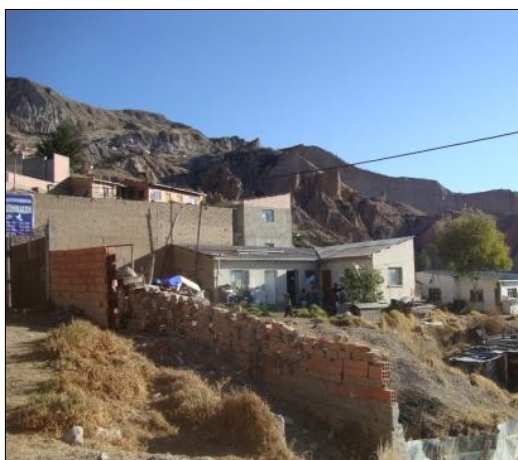
Fig. 39- Coronamiento de Talud
