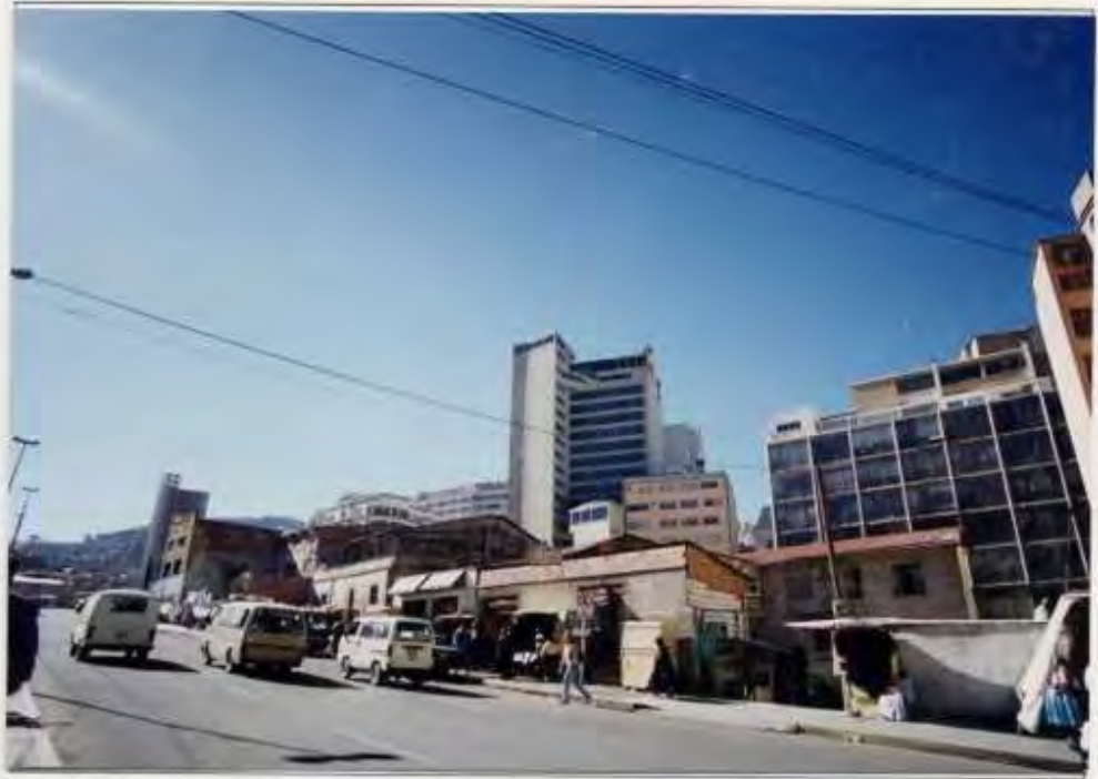
4.- Av. Mariscal Santa Cruz, zona que debe ser remodelada
