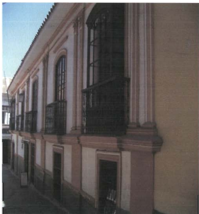
Referencia: FACHADA PRINCIPAL CALLE JAÉN Fotografía: O.OGALDE Fecha: 2012-07-31
