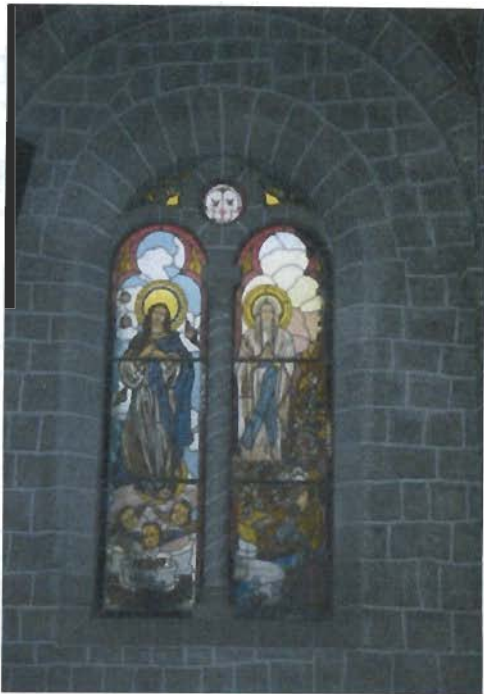
Referencia: VANOS ALARGADOS EN ARCO DE MEDIO PUNTO DIVIDIDOS POR UNA COLUMNA ENTORCHADA Y DECORADOS CON VITRALES CON IMAGENES RELIGIOSAS Fotografía: ARQ.M.CASTRO Fecha: 2009-04-29
