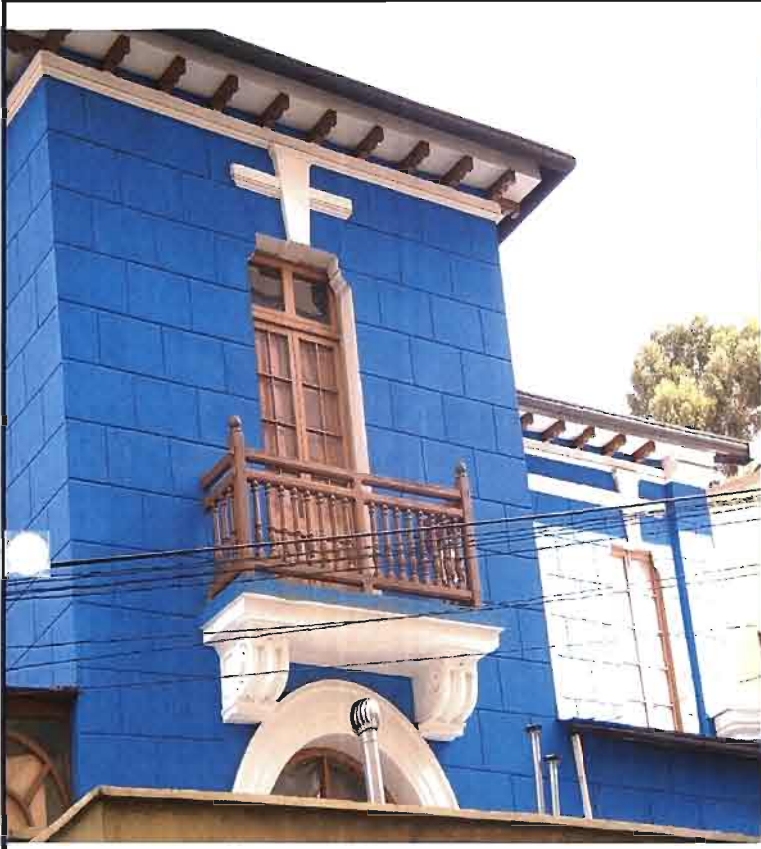
Referencia: BALCON ABIERTO TRABAJADO EN MADERA SOBRE MENSULAS Fotografía: MCASTRO Fecha: 2008-06-20
