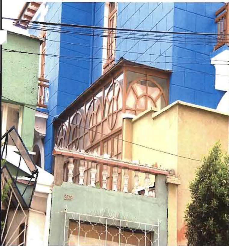
Referencia: BALCON ABIERTO TRABAJADO EN MADERA SOBRE MENSULAS Fotografía: MCASTRO Fecha: 2008-06-20
