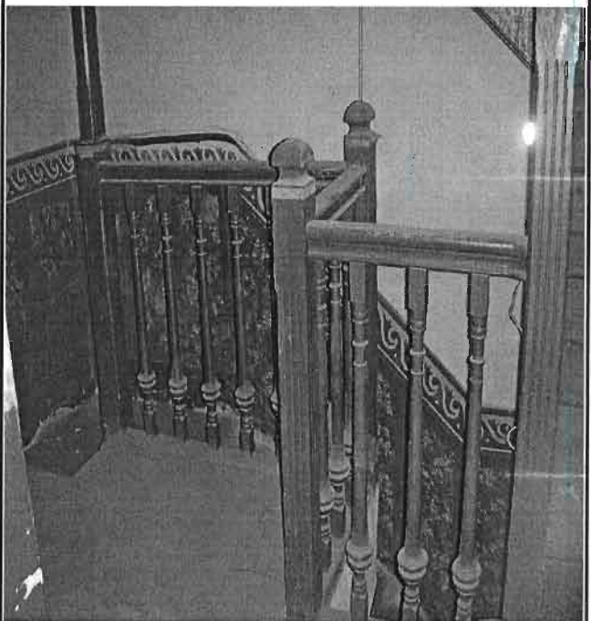
Referencia: ESCALERA PRINCIPAL Fotografía: JBARRIGA Fecha: 2013-08-02
