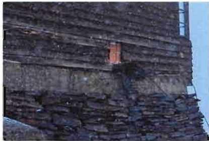
IMAGEN 19 Imagen de la losa sobre el talud de piedra
