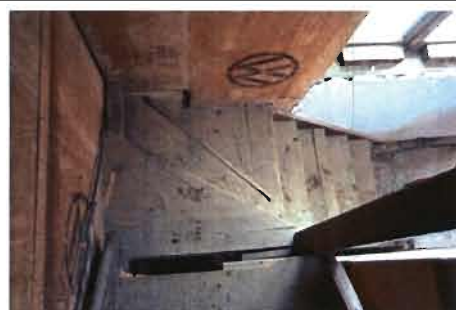
IMAGEN 28. La estructura de madera así como los peldaños contruidos en madera.
