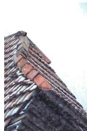
IMAGEN.27 Detalle de las cubiertas planas, y las tejas del encuentro en esquinas
