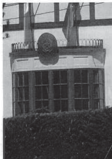
Referencia: DETALLE DEL BALCON CERRADO TRABAJADO EN MADERA Fotografía: ARQ.M.CASTRO Fecha: 2009-08-20
