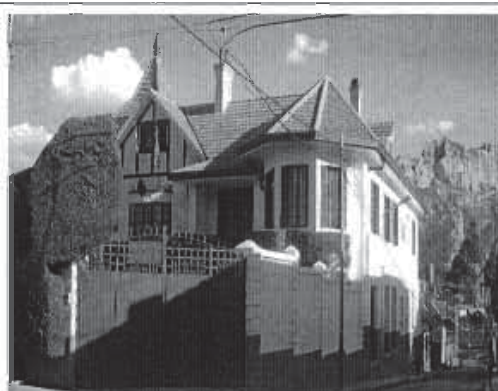
REFERENCIAS: Vista general de la edificación
