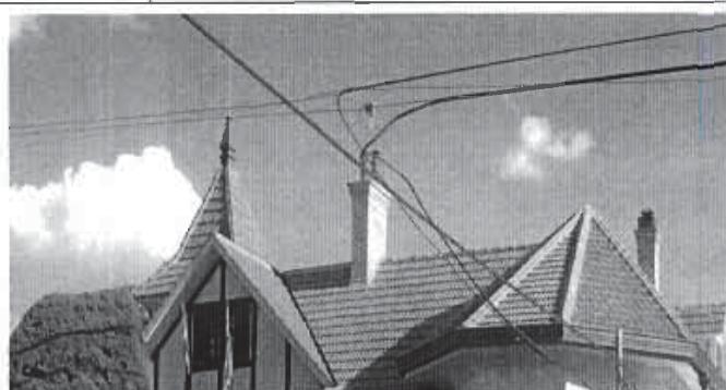
REFERENCIAS: VISTA CUBIERTAS Y CHIMENEAS
