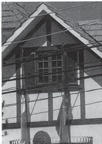
Referencia: VANO RECTO CON CARPINTERIA Y POSTIGO DE MADERA. VISTA DEL ENTRAMADO DE MADERA VISTA EN EL HASTIAL. Fotografía: ARQ.M.CASTRO Fecha: 2009-08-20
