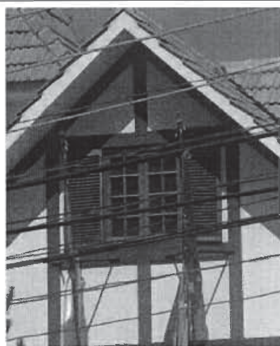
REFERENCIAS: VANO RECTO CON CARPINTERIA Y POSTIGO DE MADERA, VISTA DEL ENTRAMADO DE MADERA VISTA EN EL HASTIAL
