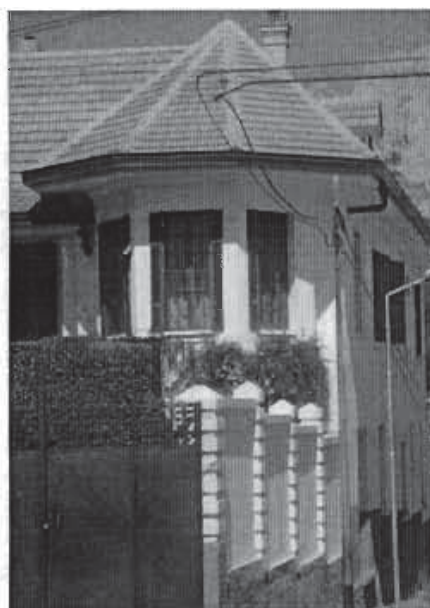
Referencia: CUERPO LATERAL DERECHO DE BASE EXAGONAL CON VANOS RECTOS. CARPINTERIA Y POSTIGOS DE MADERA Fotografía: ARQ.M.CASTRO Fecha: 2009-08-20
