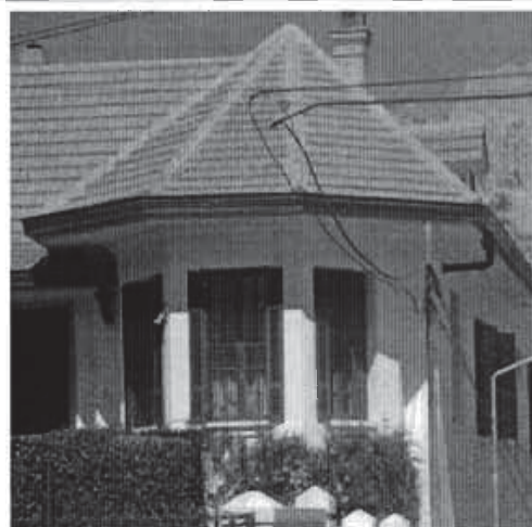
REFERENCIAS: CUERPO LATERAL DERECHO DE BASE EXAGONAL CON VANOS RECTOS, CARPINTERIA Y POSTIGOS DE MADERA
