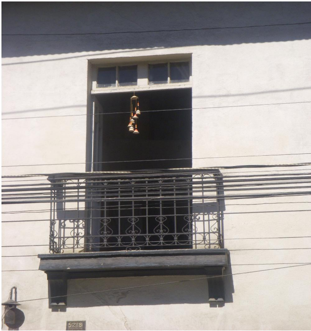
Referencia: BALCON ABIERTO CON BARANDILLA METALICA Y PUERTA CRISTALERA Fotografía: M.CASTRO Fecha: 2009-05-01
