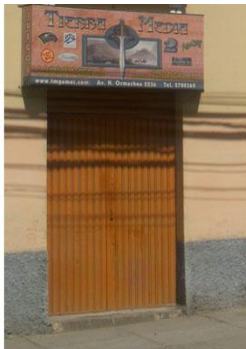
Referencia: VISTA DE LA NUEVA PUERTA METALICA TIPO CORTINA Fotografía: ARQ.M.CASTRO Fecha: 2009-05-19
