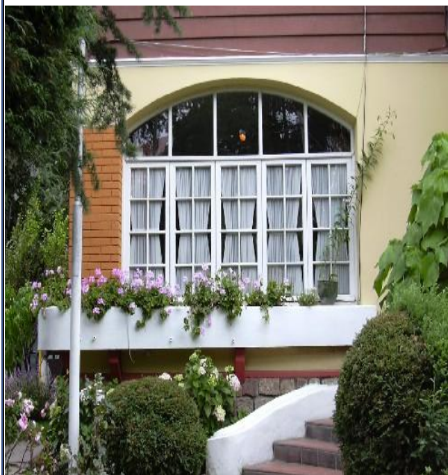
Referencia: VISTA DE UN VANO DE VENTANA EN ARCO REBAJADO Fotografía: IMAGEN DE ARCHIVO Fecha: 2010-08-30
