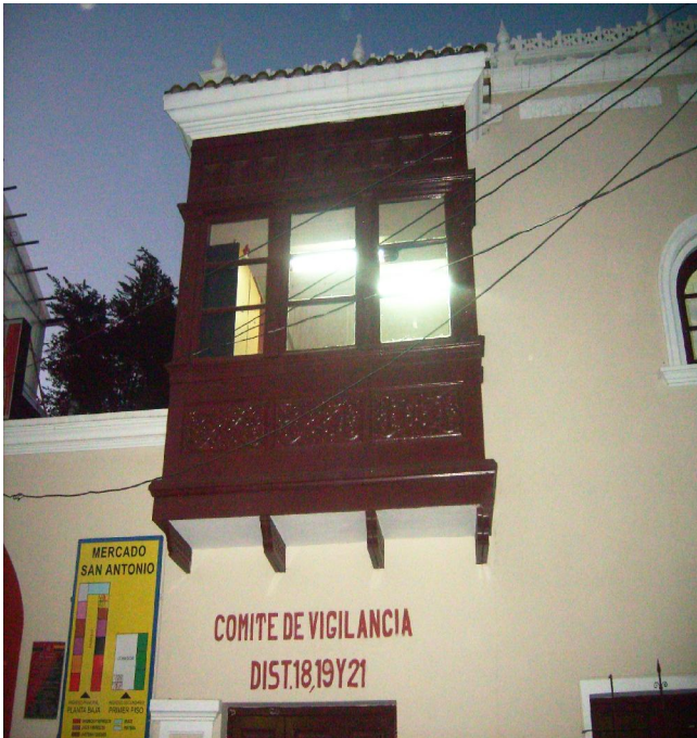
Referencia: DETALLE DEL BALCON CERRADO REVESTIDO CON MADERA TALLADA Fotografia: ARQ.M.CASTRO Fecha: 2009-05-22
