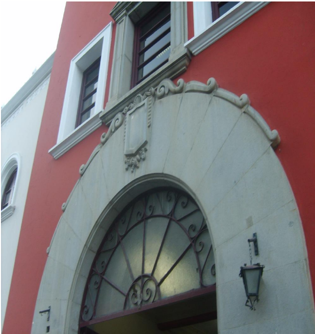
Referencia: ARCO DE PIEDRA CON EL DETALLE DE DOVELAS Y PIEZA CLAVE Fotografia: ARQ.M.CASTRO Fecha: 2009-05-22
