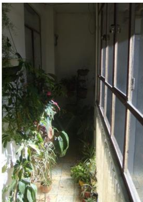
Referencia: VISTA DEL PASILLO ENFAROLADO DEL INTERIOR Fotografía: ARQ.M.CASTRO Fecha: 2009-05-26
