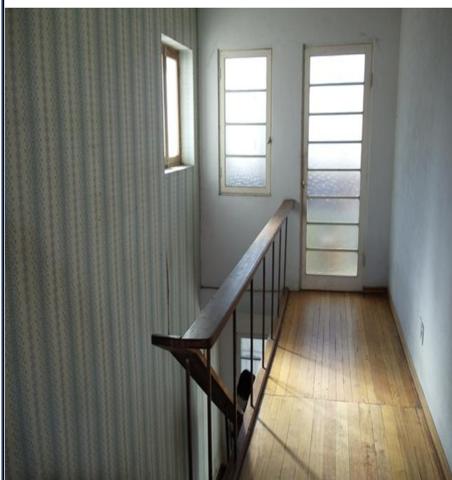
Referencia: IMAGEN DE LAS ESCALERAS INTERIORES EN EL INMUEBLE DE LA CALLE 11 Fotografía: OGALDE Fecha: N/A
