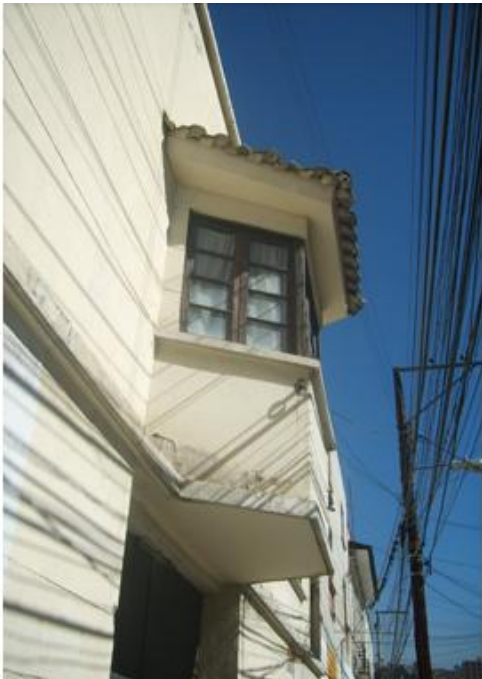
Referencia: VISTA DEL BALCON CERRADO CON FORMA SEMIHEXAGONAL Fotografía: ARQ.M.CASTRO Fecha: 2009-05-25
