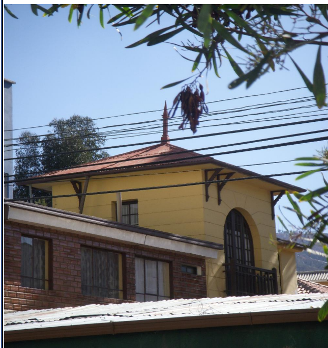
Referencia: DETALLE DE LA TORRE Fotografía: OGALDE Fecha: N/A
