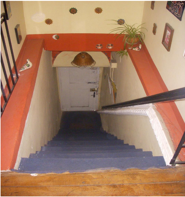
Referencia: VISTA DE LAS ESCALERAS RECTAS DE MADERA Fotografía: M.CASTRO Fecha: 2009-05-01
