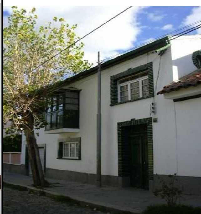
Referencia: VISTA DE LA FACHADA LATERAL Fotografía: IMAGEN DE ARCHIVO Fecha: 2010-08-26
