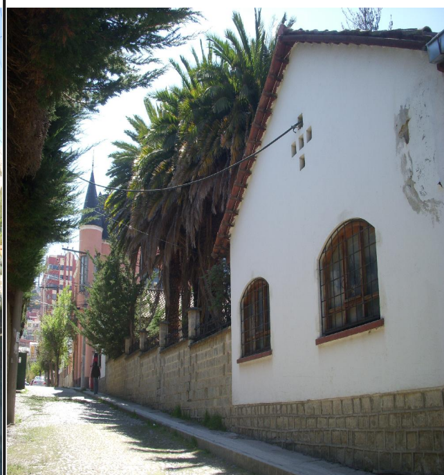
Referencia: BLOQUE LATERAL CALLE 9 Fotografía: OGALDE Fecha: N/A
