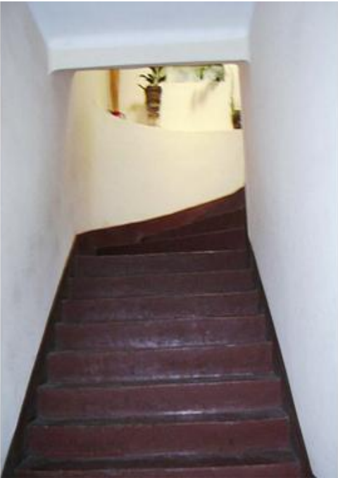
Referencia: VISTA DE LA ESCALERA DE CONCRETO INTERIOR Fotografía: IMAGEN DE ARCHIVO Fecha: 2010-08-25
