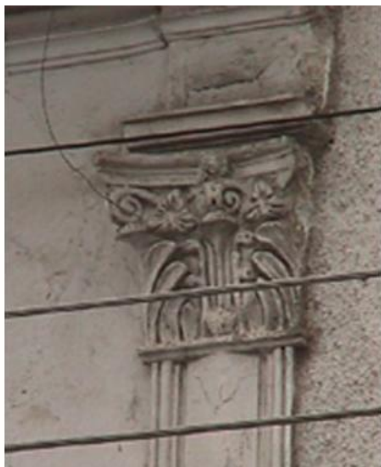
Referencia: VISTA DE PILASTRA CON CAPITEL DE LA FACHADA PRINCIPAL Fotografía: IMAGEN DE ARCHIVO Fecha: 2009-05-26
