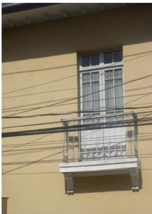
Referencia: BALCON ABIERTO SOBRE MENSULAS, CON BARANDILLA METALICA Y PUERTA CRISTALERA Fotografía: ARQ.M.CASTRO Fecha: 2009-05-19
