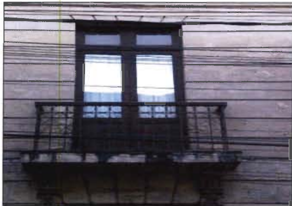
DETALLE DE BALCON
