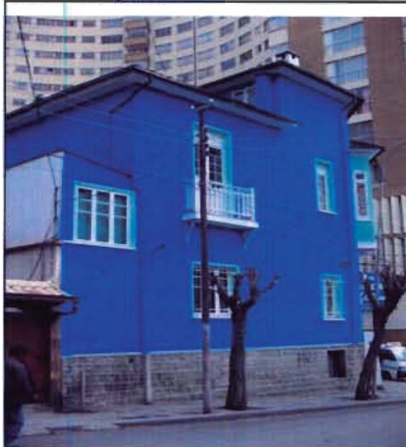
Referencia: FACHADA CALLE AGUSTIN ASPIAZU CON BALCON ABIERTO CENTRAL Fotografía: N/A Fecha: N/A
