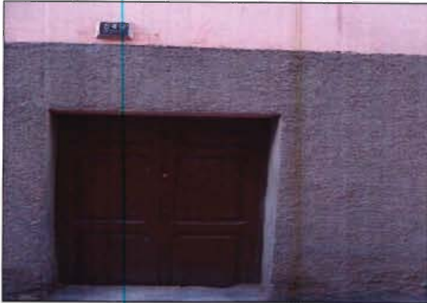
PUERTA DE INGRESO AL INMUEBLE
