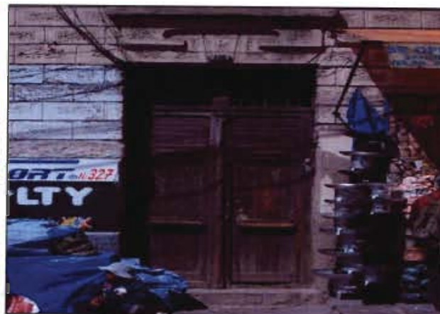
PUERTA DE MADERA DE INGRESO AL INMUEBLE
