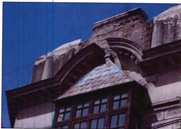
PARAPETO MOLDURADO EN REMATE DEL INMUEBLE
