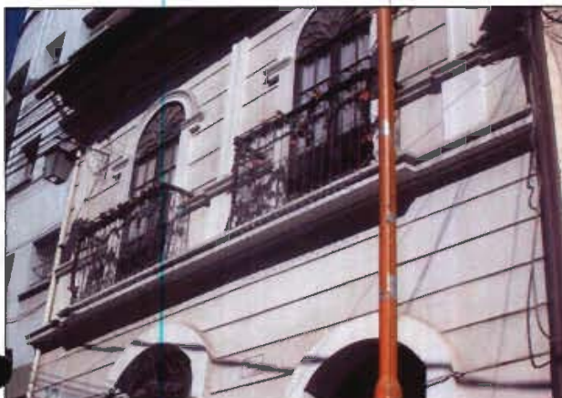
AVITOLADO EN FACHADA
