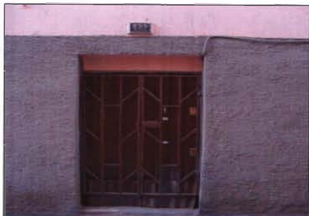
PUERTA DE INGRESO AL INMUEBLE
