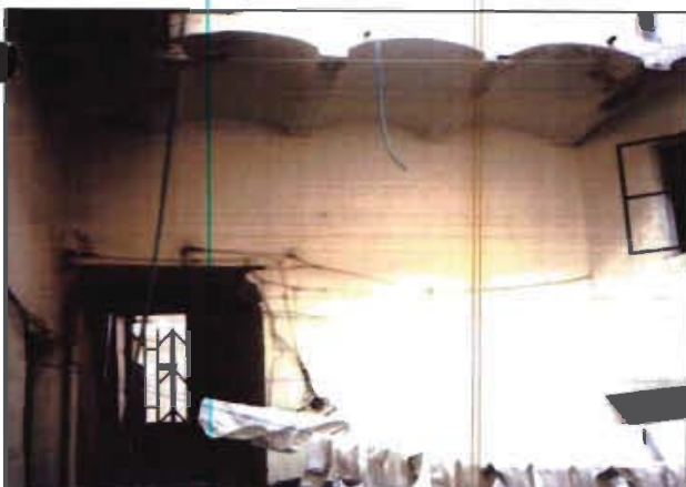
VISTA BOVEDILLAS GALERÍA
