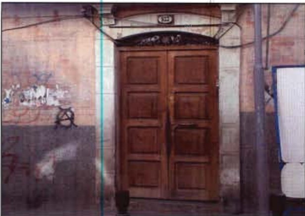
PUERTA DE ACCESO-ARCO REBAJADO
