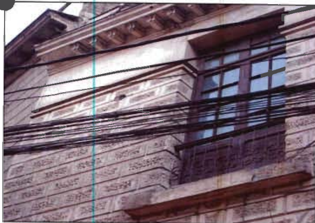
BALCONCILLO - CORNISA DENTICULADA - ALMOHADILLADO
