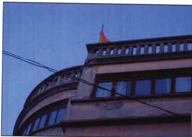
BALAUSTRADO EN REMATE DE LA EDIFICACION
