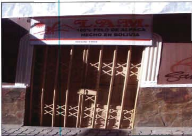
PUERTA DE INGRESO LOCAL COMERCIAL
