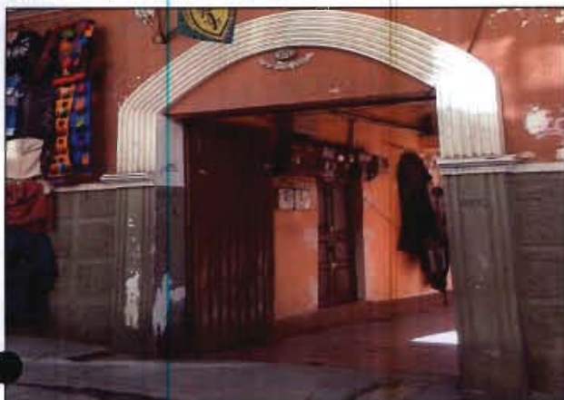
PUERTA DE INGRESO PRINCIPAL
