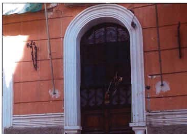
PUERTA DE INGRESO MODIFICADA
