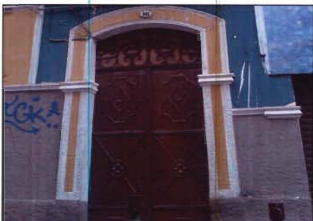
PUERTA PRINCIPAL DE INGRESO
