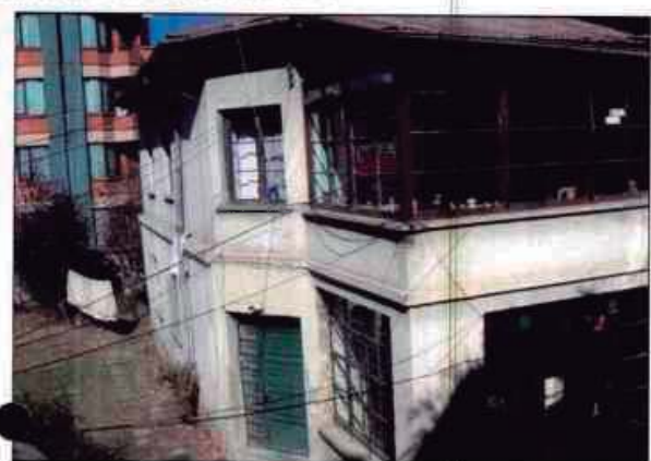
VISTA FACHADAS - NOROESTE
