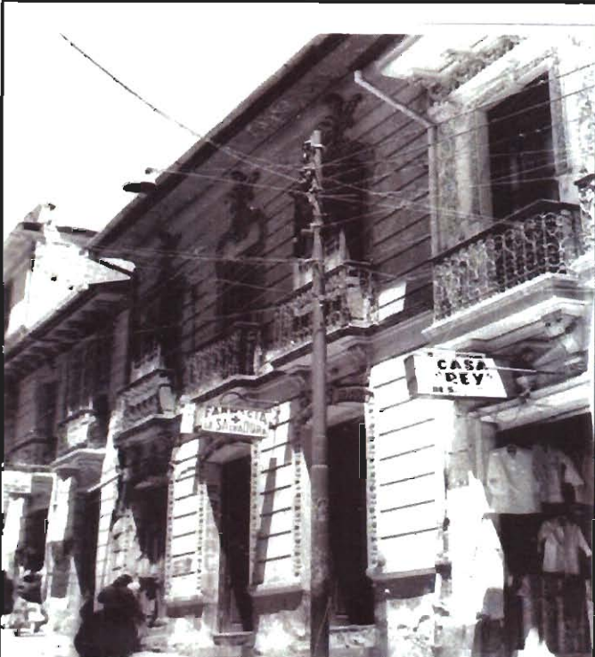
Referencia: FACHADA CALLE SAGARNAGA - FOTOGRAFIA DE ARCHIVO Fotografía: N/A Fecha: N/A
