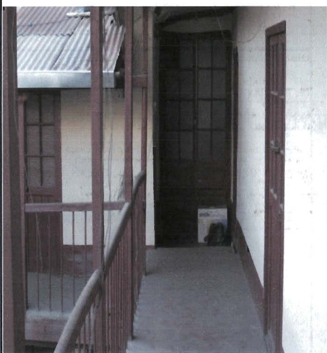
Referencia: VISTA DEL PASILLO Fotografía: C.CARRASCO Fecha: 2011-09-05
