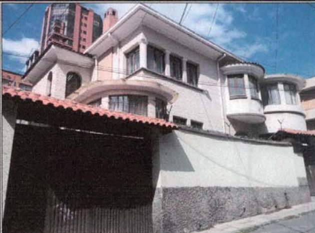
VOLÚMENES DE BASE CILÍNDRICA Y PLANOS COMPONEN LA FACHADA PRINCIPAL
