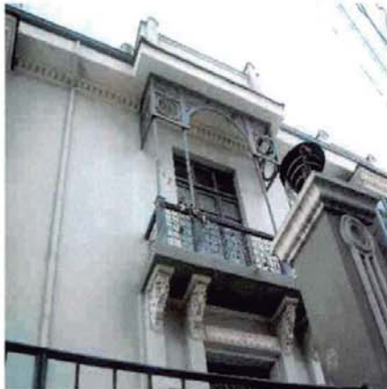
BALCON ABIERTO CON PUERTA CRISTALERA Y BARANDILLA DE METAL SOPORTADA POR MAMPOSTERÍA
