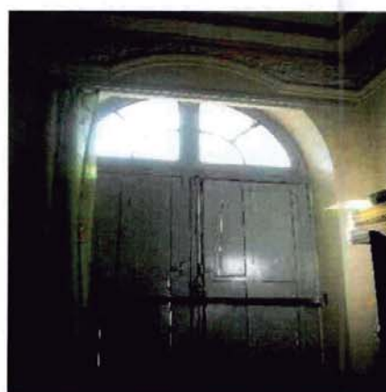
VANO DE VENTANA EN ARCO DE MEDIO PUNTO CON CONTE
