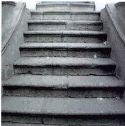
ESCALINATAS DE PIEDRA ACCESO PRINCIPAL
