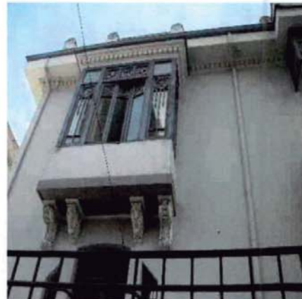
BALCON ABIERTO CON PUERTA CRISTALERA Y BARANDILLA DE METAL SOPORTADA POR MAMPOSTERÍA
