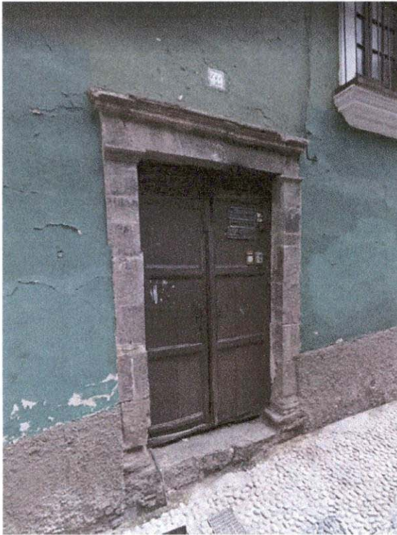
PORTADA EN PIEDRA EN FACHADA
