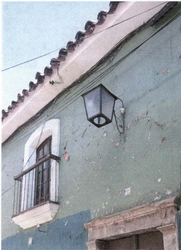
VISTA CUBIERTA DE TEJA Y ALERO SENCILLO
