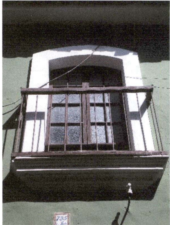
BALCONCILLO CON BARANDA METÁLICA Y PASAMANOS DE MADERA
