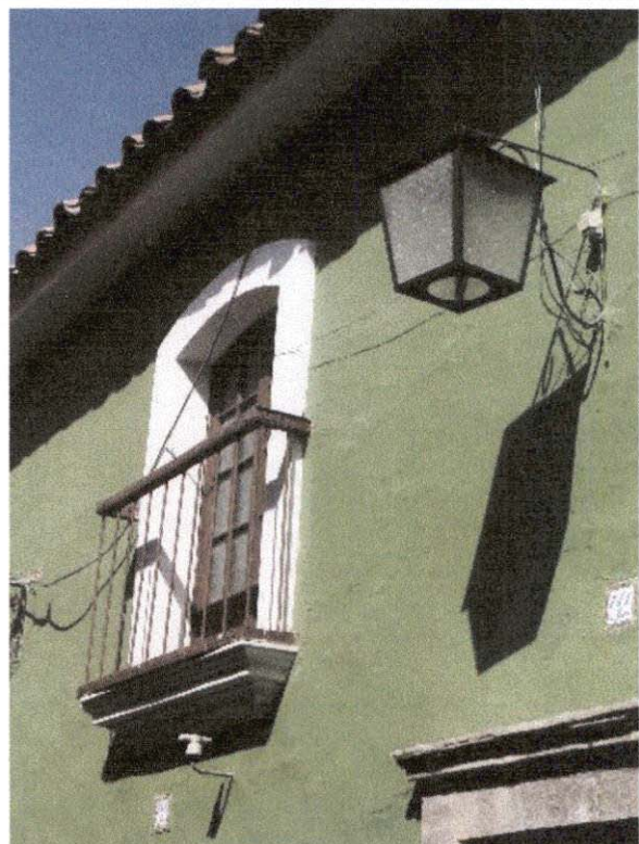
VANO CON ARCO REBAJADO Y RECUADRO
