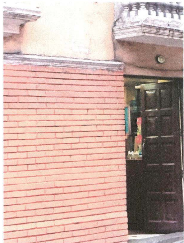
ZÓCALO INFERIOR EN LADRILLO VISTO
