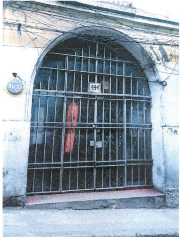
VANO ENSANCHADO EN ARCO DE MEDIO PUNTO
