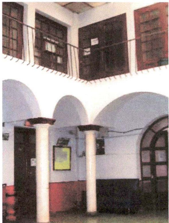
VISTA DE PATIO CENTRAL ANTES DE TRABAJOS DE DEMOLICIÓN (ARCHIVO SIPATAC)
