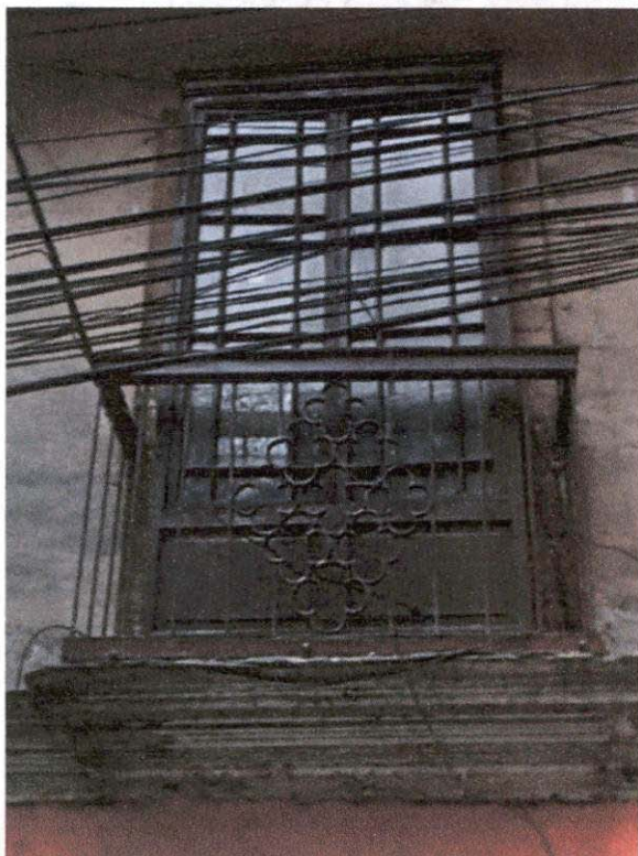
DETALLE DE ORNAMENTACIÓN EN BARANDA DE HIERRO FORJADO
