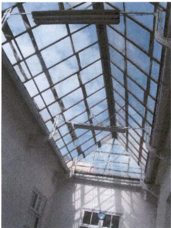
VISTA INTERIOR DE TRAGA LUZ (ARCHIVO SIPATAC)
