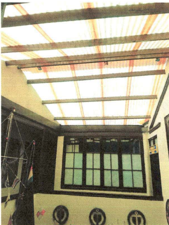
CUBIERTA HACIA EL INTERIOR EN PATIO CENTRAL
