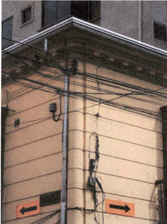
ESQUINA DE INMUEBLE EN ACABADO CURVO
