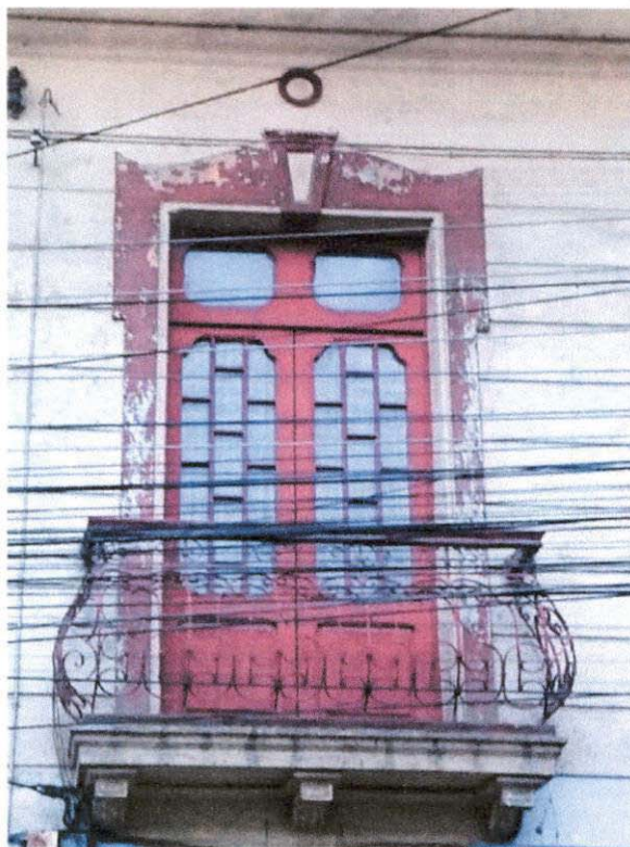
BALCÓN ABIERTO CON BARANDADO EN HIERRO FORJADO TIPO CÓNCAVO
