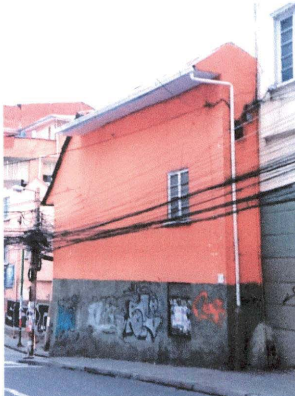
FACHADA LATERAL SOBRE CALLE OBISPO CÁRDENAS
