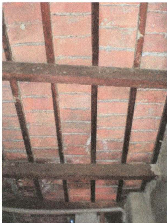
ENTREPISO CON VIGAS DE MADERA Y LADRILLO GAMBOTE (ARCHIVO SIPATAC)
