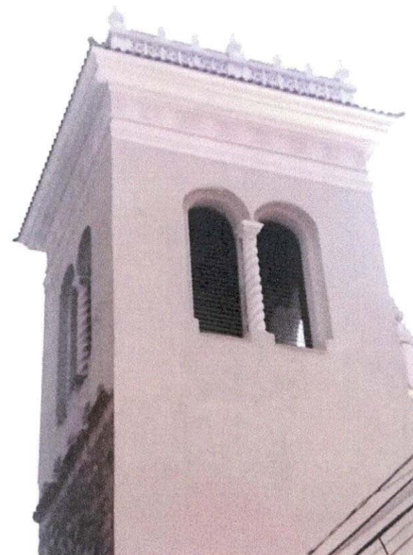
TORRE CON VANO BIFORO Y COLUMNA SALOMONICA
