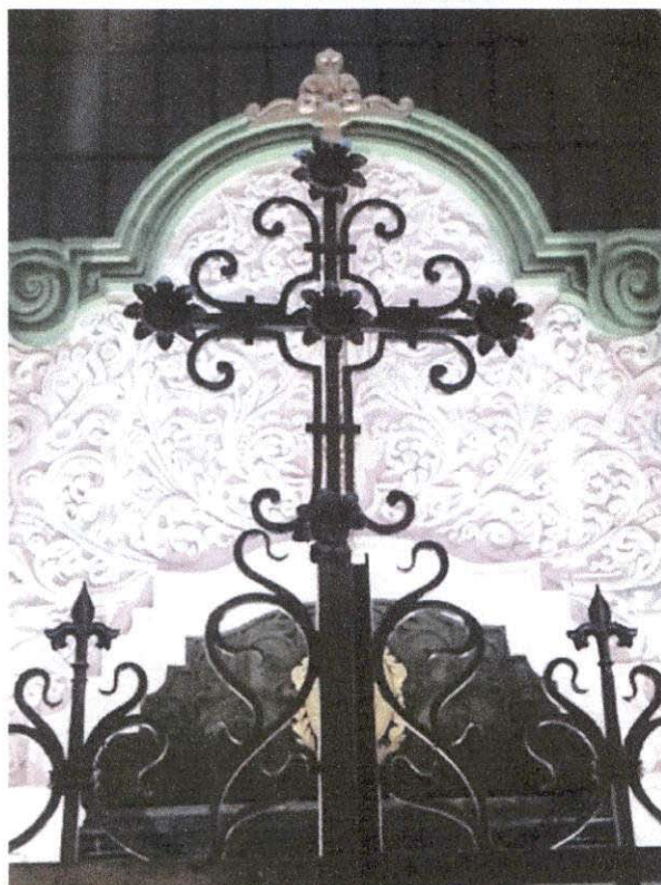
DETALLE DE CRUZ EN ENREJADO PERIMETRAL DEL PREDIO
