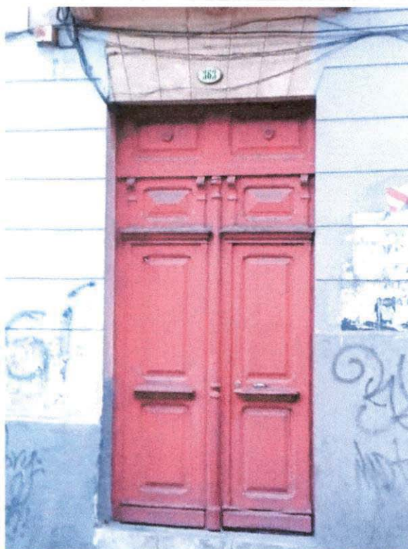
VANO RECTO DE INGRESO PRINCIPAL, CON PORONES DE MADERA Y MONTANTE
