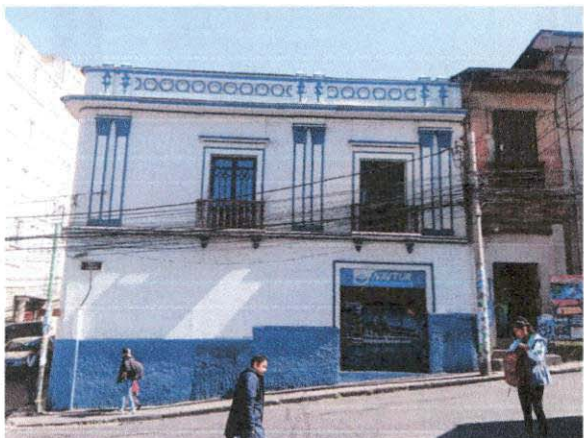
VISTA FACHADA LATERAL
