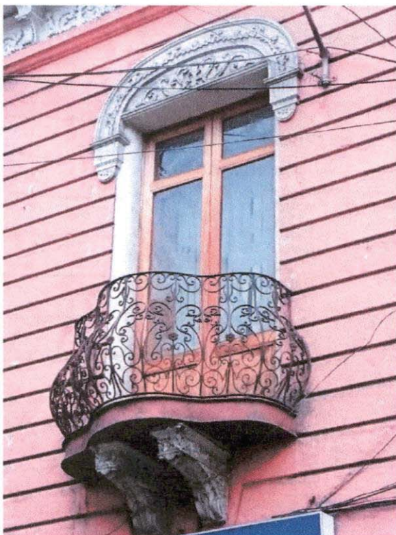
BALCÓN ABIERTO CON BARANDA DE HIERRO FORJADO SOBRE REPISÓN CON MENSULAS
