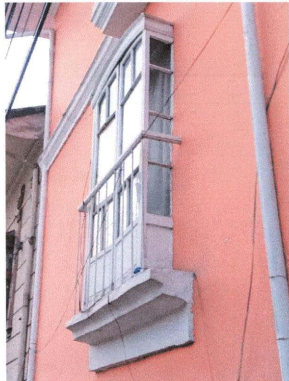
BALCÓN DE CAJÓN EN VANO DE ARCO REBAJADO CON BARANDA SENCILLA EN HIERRO
