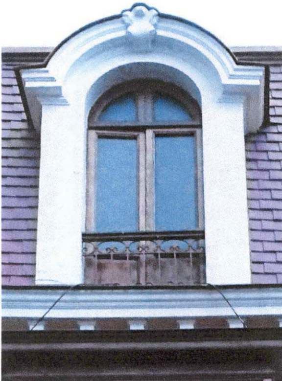
VANO DE VENTANA EN ARCO DE MEDIO PUNTO
