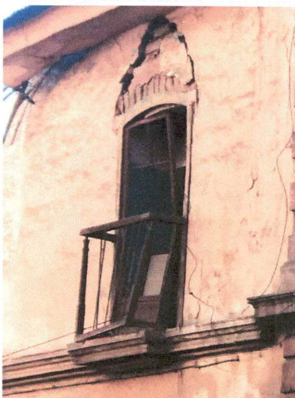
RESTOS DE BALCÓN ABIERTO EN VANO DE ARCO REBAJADO (SOBRE CALLE BUENO)
