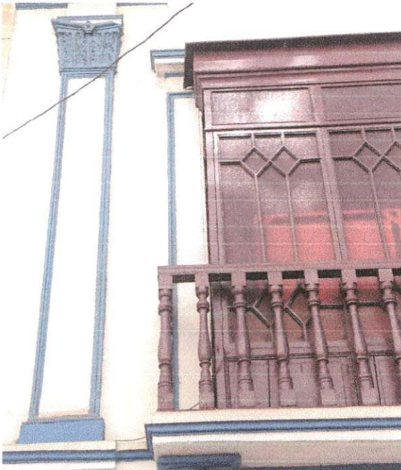
DETALLE ORNAMENTACIONES EN BALCON CERRADO
