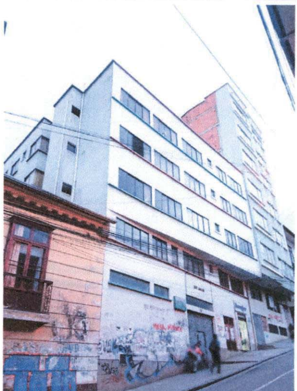
EDIFICACIÓN TIPO TORRE ADJUNTA A BLOQUE PATRIMONIAL
