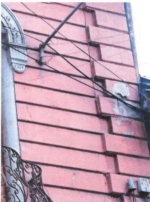
MURO CON ACABADO TIPO AVITOLADO
