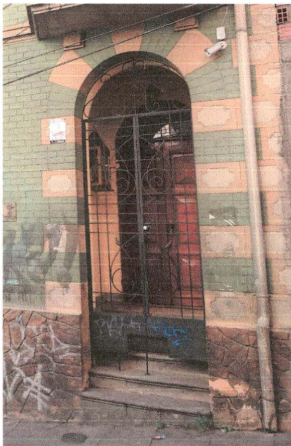
VANO DE INGRESO PRINCIPAL EN ARCO DE MEDIO PUNTO CON ENREJADO EN HIERRO FORJADO
