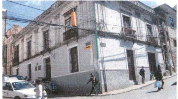
FACHADA PREVIA RESTAURACIÓN (2010)
