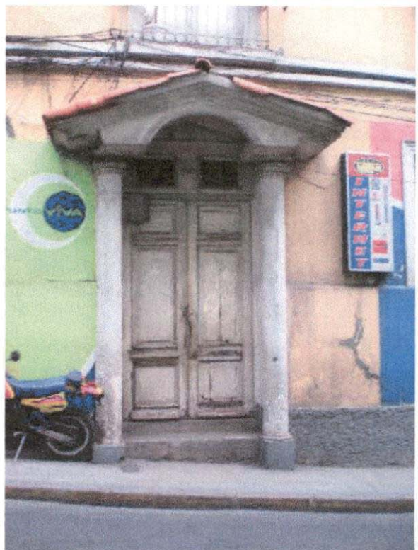
VANO RECTO PRINCIPAL DE INGRESO CON AÑADIDO POSTERIOR
