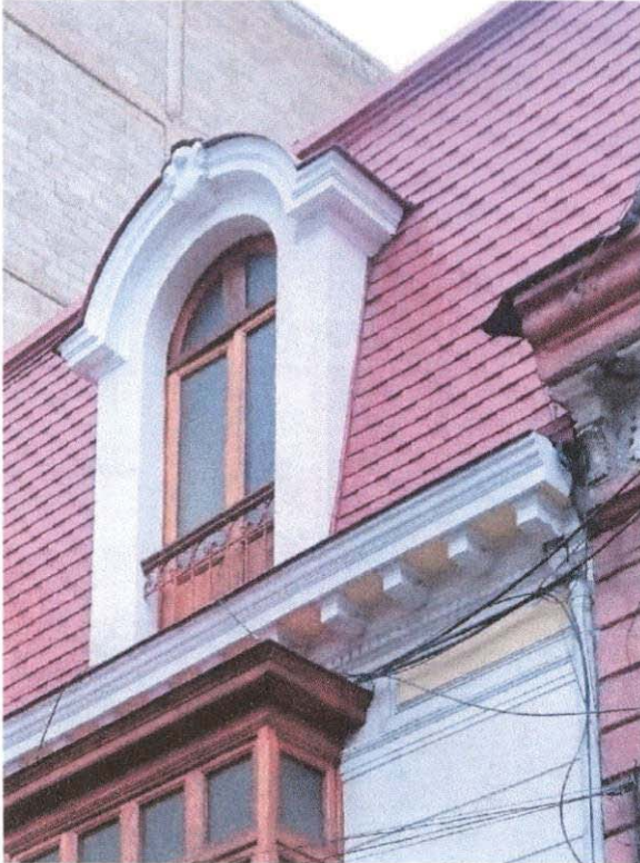
CUBIERTA EN MANSARDA
