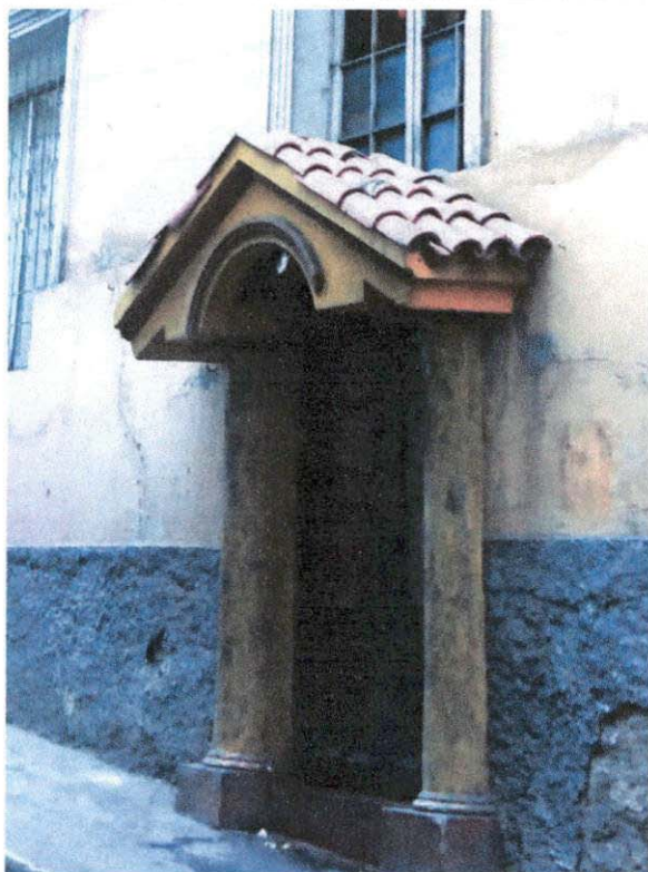
VANO RECTO CON COLUMNAS Y CUBIERTAS AÑADIDAS
