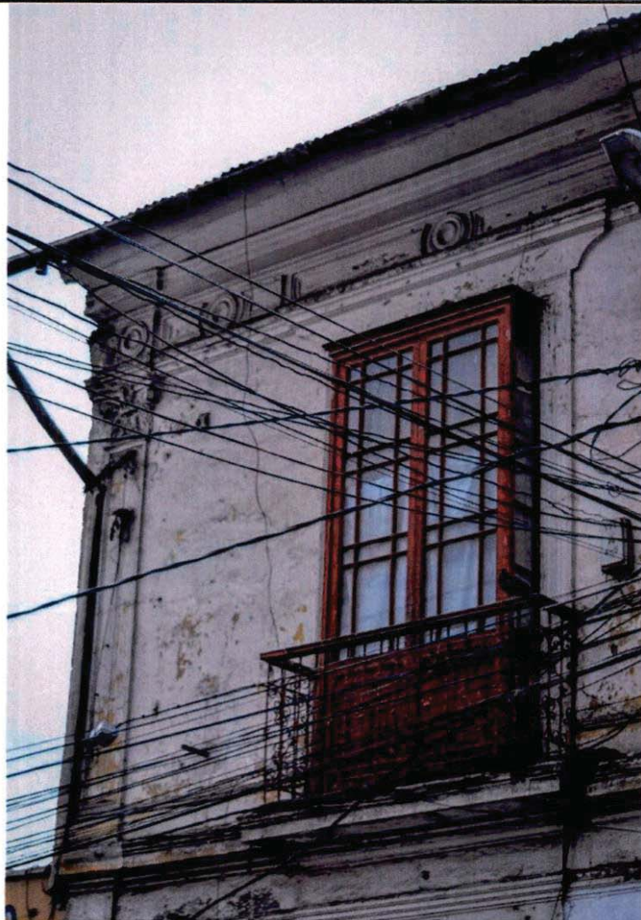
Detalle de esquina de fachada
