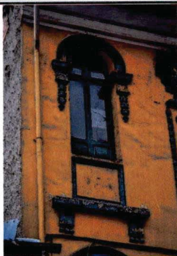
Detalle de vano arco de medio punto
