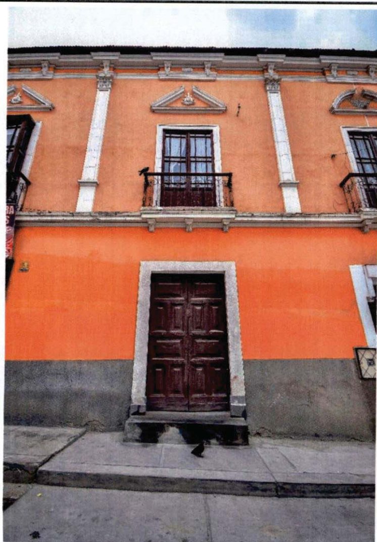
vista de un módulo de la fachada
