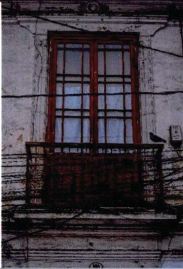
Detalle de balcón e caja
