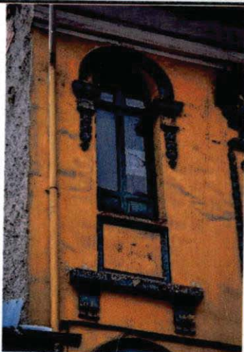
Detalle de vano arco de medio punto
