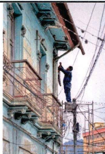
vistaparcial de fachada
