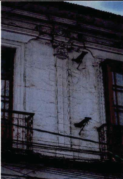
Detalle de pilastra
