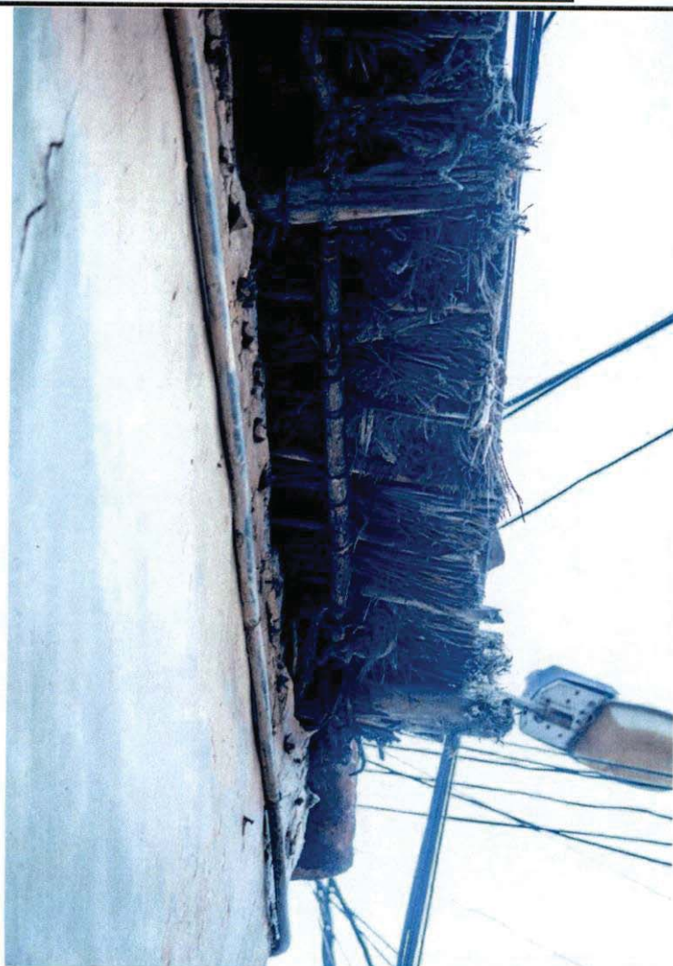
Vista de detalle de estructura de cubierta
