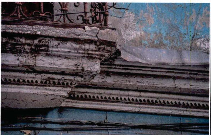
Vista de detalle de platabanda
