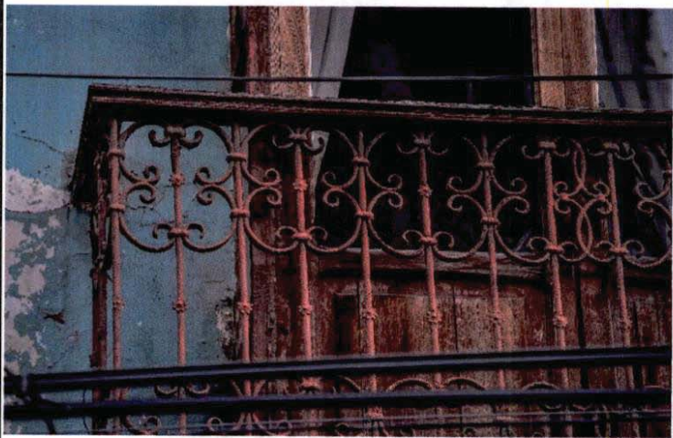
Vista de detalle de enrejado de balcón
