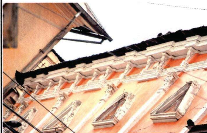
Detalle de fachada
