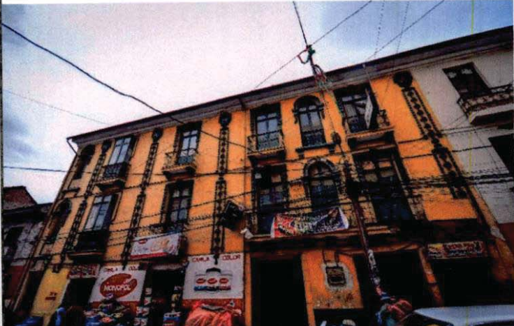
Vista de fachada
