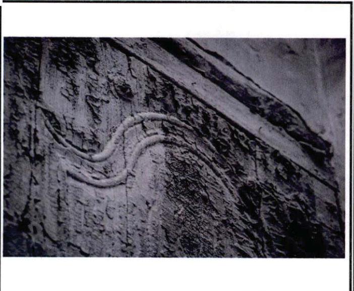
Detalle de puerta
