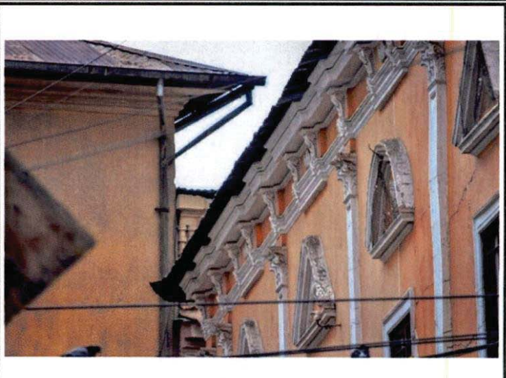
Detalle de fachada
