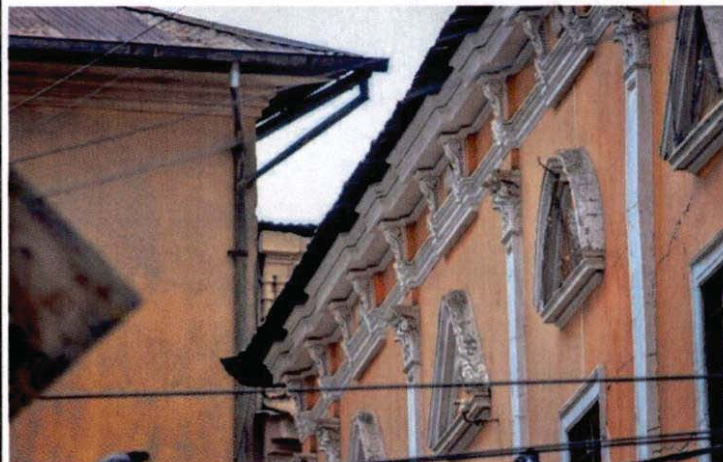
Detalle de fachada
