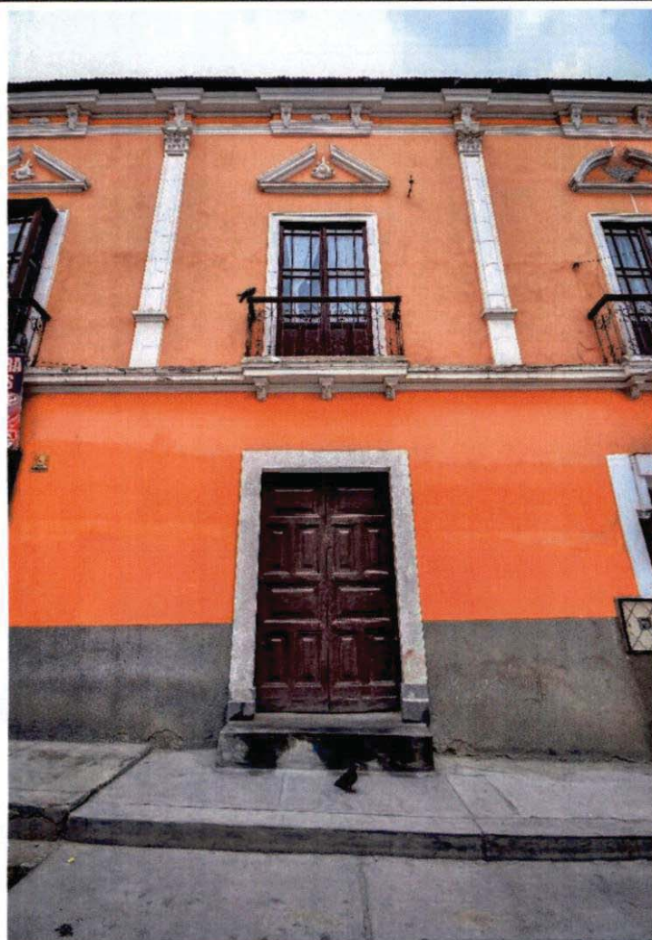
vista de un módulo de la fachada
