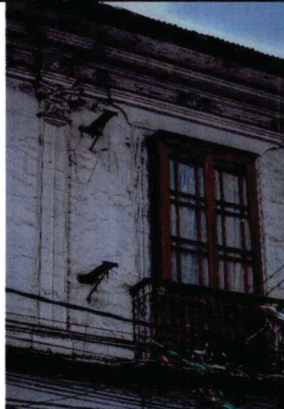
Detalle de fachada
