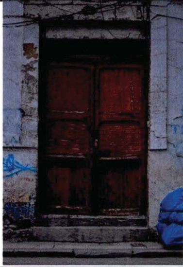
Detalle de puerta
