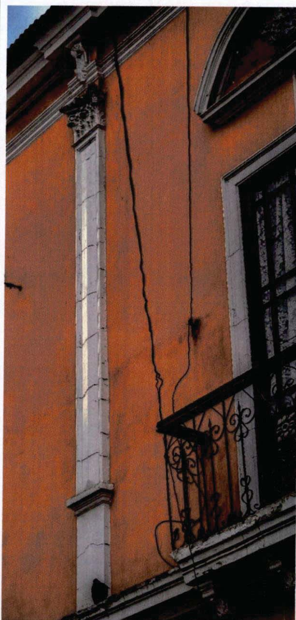
detalle de pilastra
