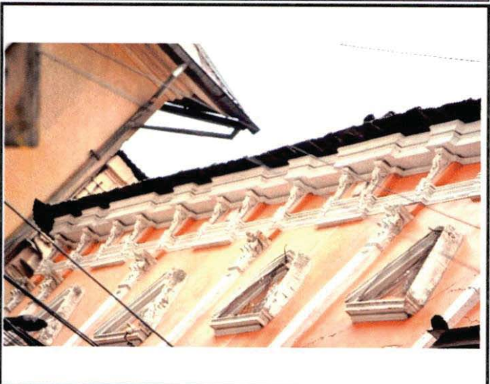
Detalle de fachada
