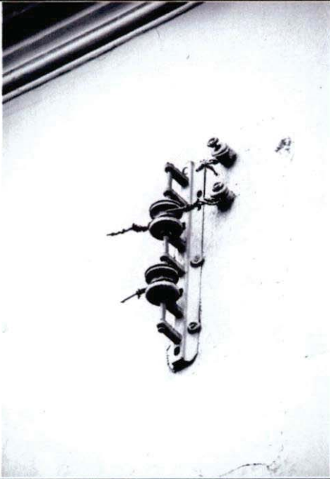
detalle sobre la fachada
