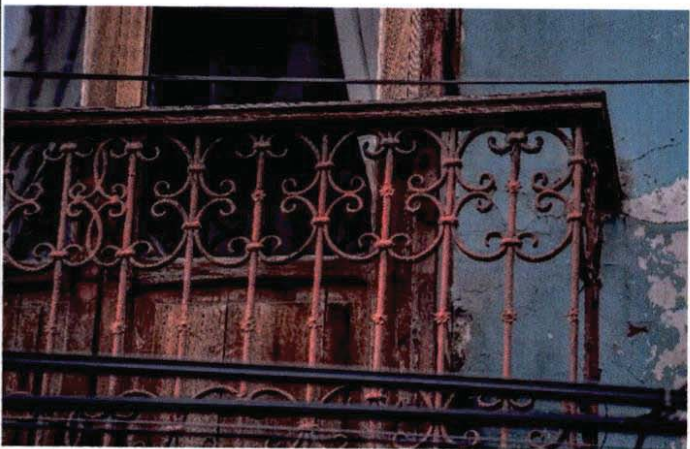
Vista de detalle de enrejado de balcón
