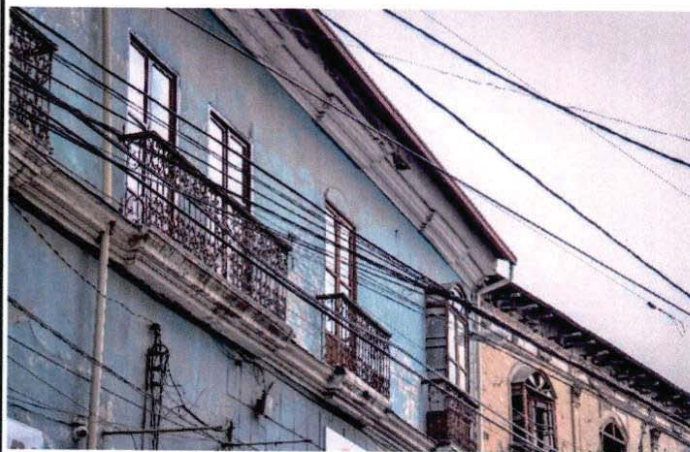
Vista parcial de fachada en la segunda planta
