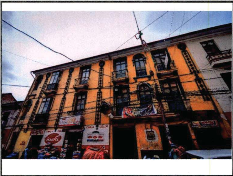
Vista de fachada
