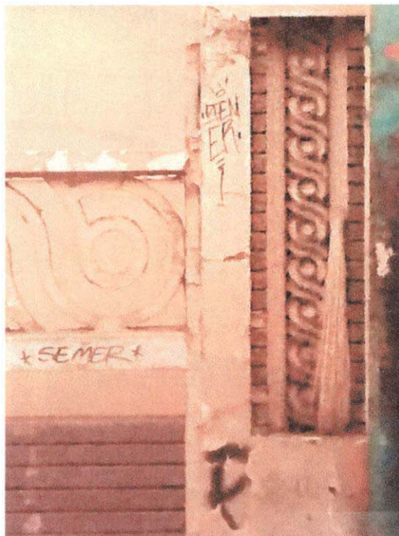
DISEÑOS DE LA ÉPOCA SOBRE EL MURO PERIMETRAL
