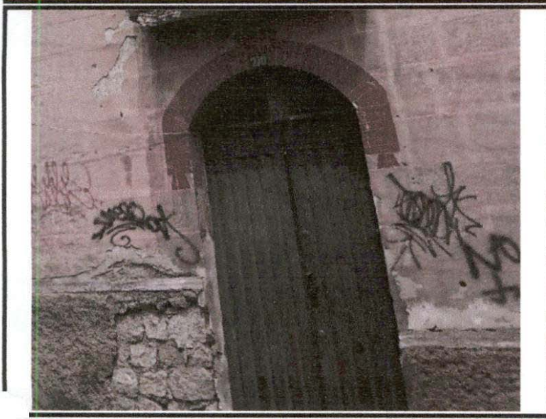
1er. nivel - Forma original del vano
