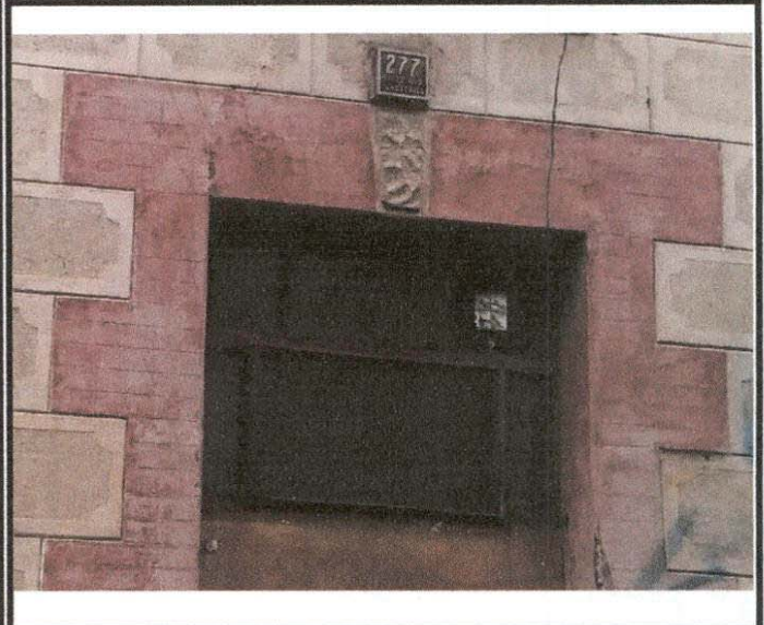
Vanos enmarcados con dovelas y clave central
