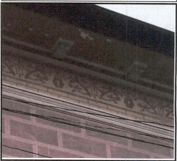
Cornisamento ornamentado y ménsulas
