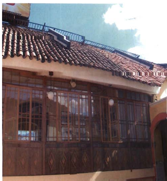
Referencia: BALCON CORRIDO CON CARPINTERIA DE MADERA Fotografía: N/A Fecha: N/A
