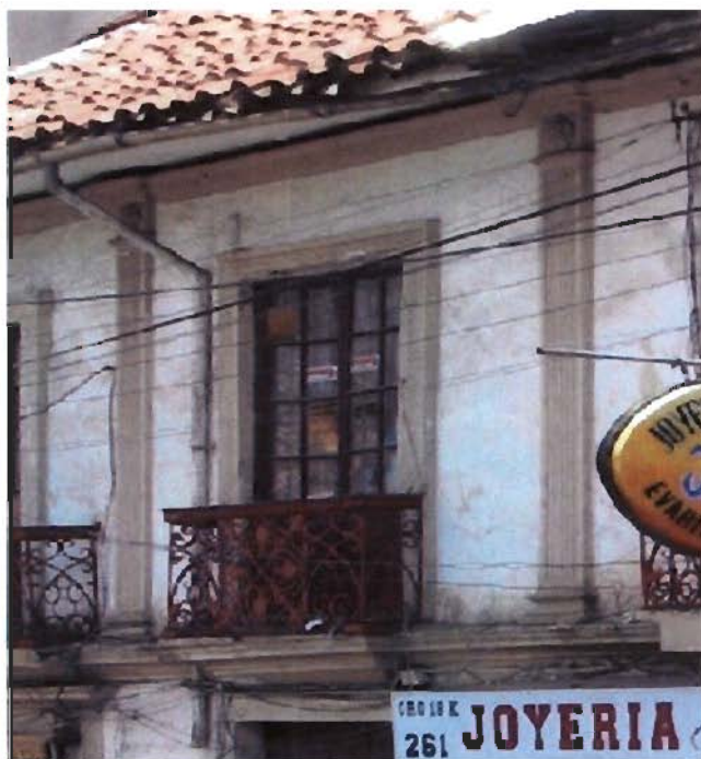
Referencia: BALCON ABIERTO CON BARANDILLA METALICA Y PUERTA CRISTALERA CON RECUADRO Fotografía: N/A Fecha: N/A
