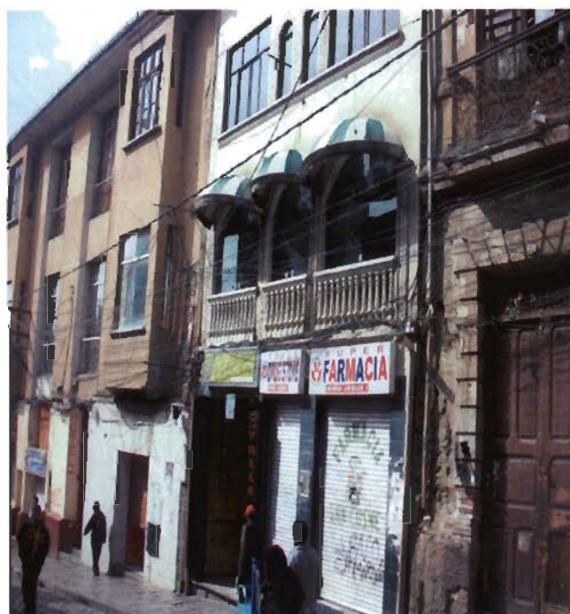
Referencia: DETALLE MARQUESINAS Fotografía: JBARRIGA Fecha: 2013-10-01
