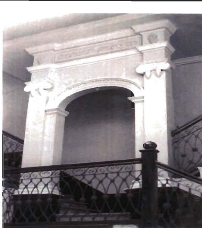
Referencia: DETALLE DE PORTADA AL INTERIOR DEL INMUEBLE - FOTOGRAFIA DE ARCHIVO Fotografía: N/A Fecha: N/A
