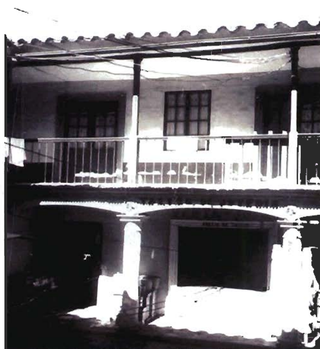
Referencia: VISTA DEL CORREDOR - FOTOGRAFIA DE ARCHIVO Fotografía: N/A Fecha: N/A
