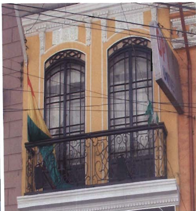
Referencia: DETALLE DE BALCÓN CORRIDO Fotografía: JBARRIGA Fecha: 2013-09-06
