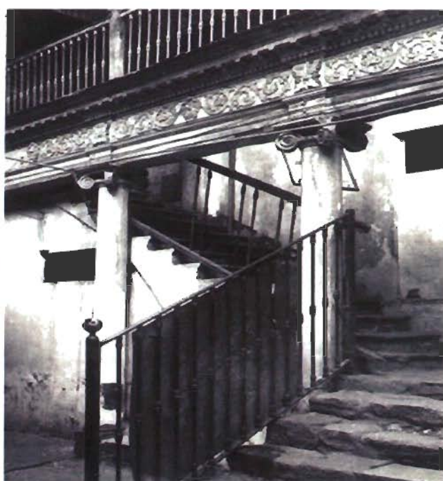
Referencia: VISTA DE LAS ESCALERAS - FOTOGRAFIA DE ARCHIVO Fotografía: N/A Fecha: N/A
