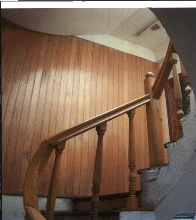
Referencia: ESCALERA INTERIOR Fotografía: JBARRIGA Fecha: 2013-02-28
