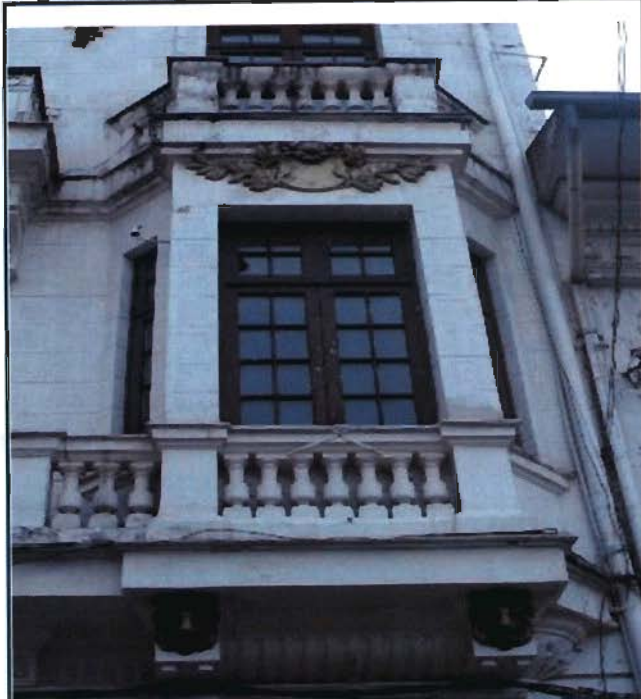
Referencia: BALCON DE CAJÓN Fotografía: JBARRIGA Fecha: 2013-02-18
