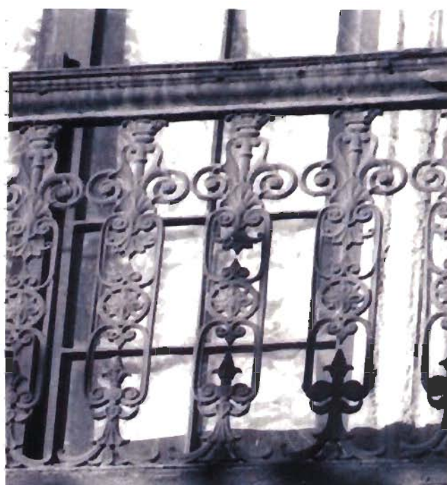
Referencia: DETALLE DE BARANDILLA METALICA - FOTOGRAFIA DE ARCHIVO Fotografía: N/A Fecha: N/A
