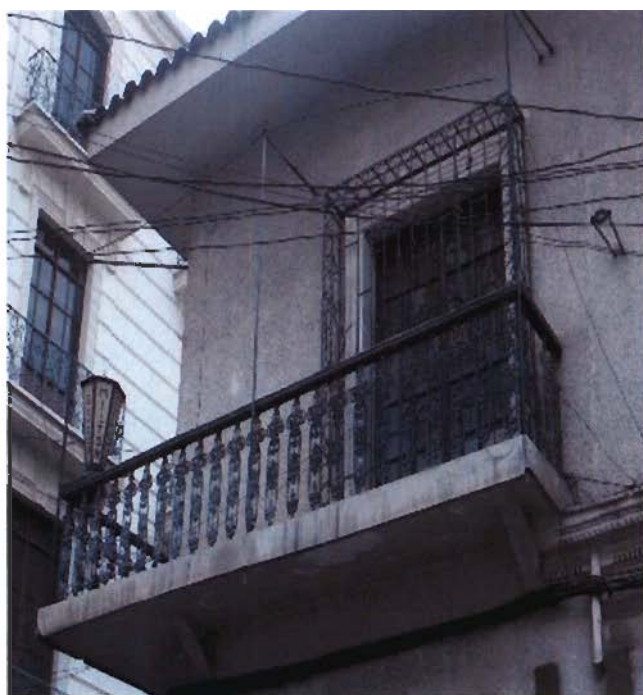
Referencia: BALCON Fotografía: JBARRIGA Fecha: 2013-02-18
