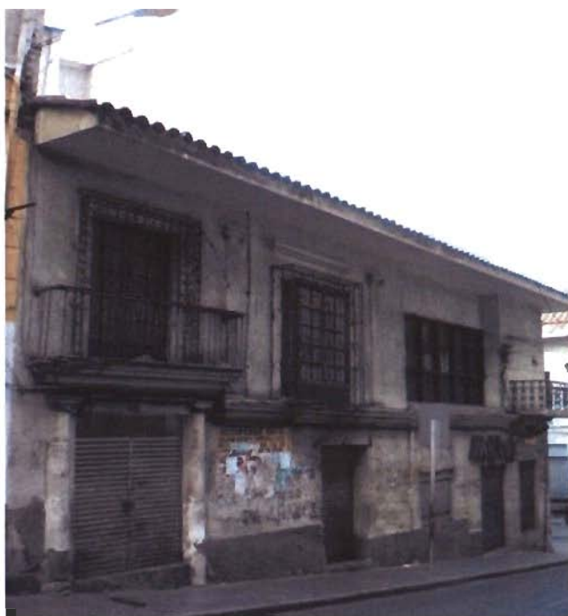
Referencia: FACHADA LATERAL Fotografía: JBARRIGA Fecha: 2013-02-18
