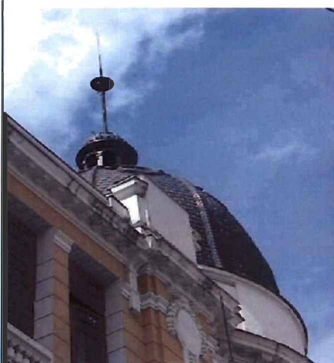
Referencia: DETALLE DE CUPULA Fotografía: N/A Fecha: N/A
