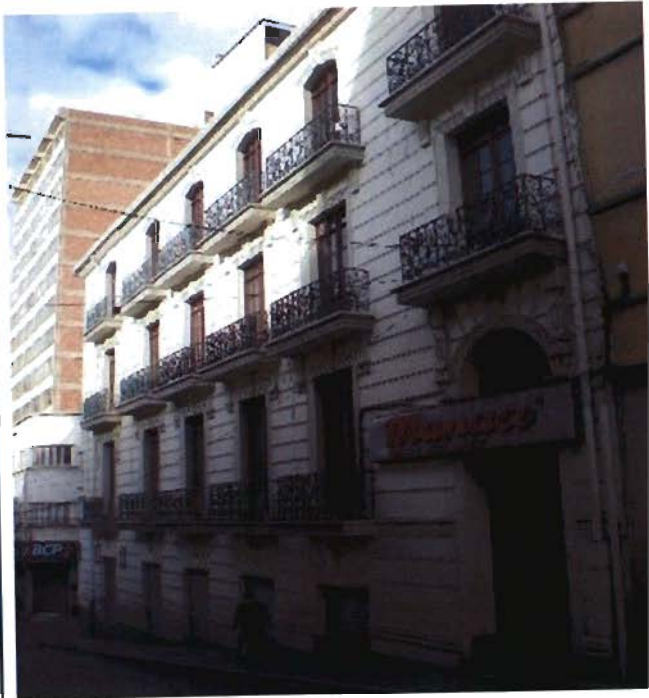
Referencia: FACHADA YANACOCOA Fotografía: JBARRIGA Fecha: 2013-02-20
