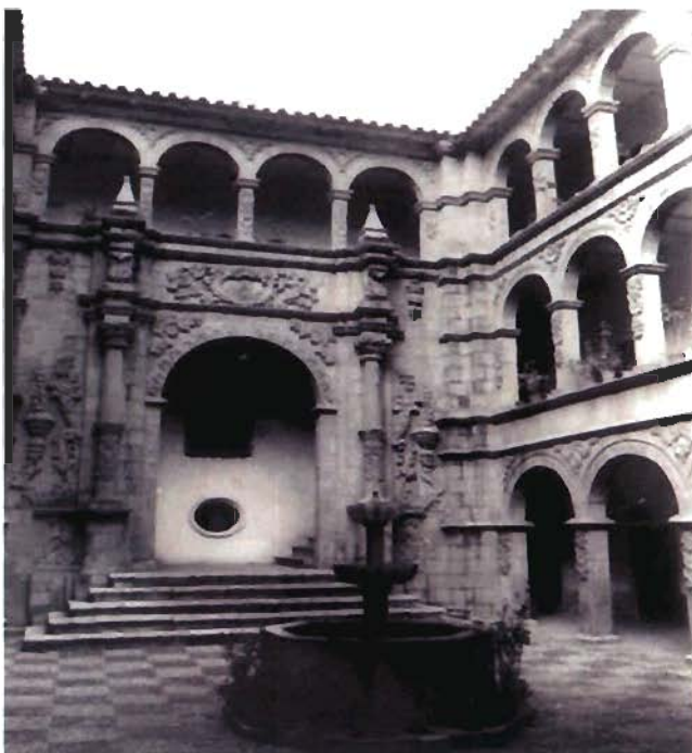
Referencia: VISTA DEL PATIO INTERIOR - FOTOGRAFIA DE ARCHIVO Fotografía: N/A Fecha: N/A
