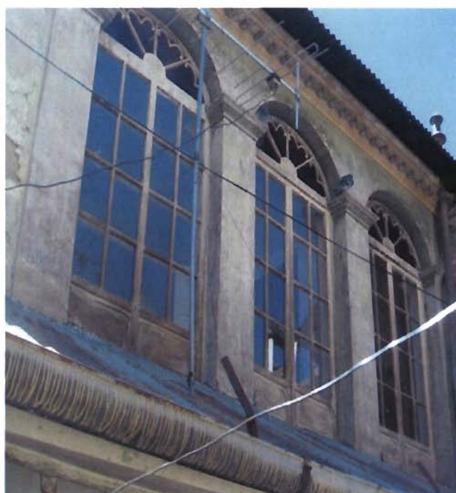
Referencia: LOGGIA Fotografía: O. OGALDE Fecha: 2009-06-01
