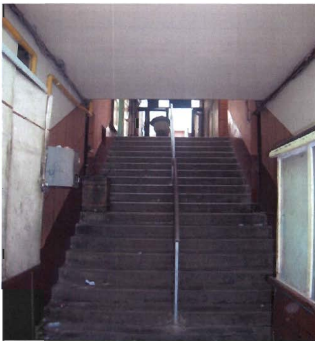
Referencia: ESCALERAS DE ACCESO AL SEGUNDO NIVEL Fotografía: PCARVALLO Fecha: 2008-07-17
