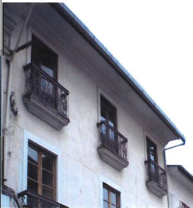
Referencia: DETALLE EXTERIOR Fotografía: JBARRIGA Fecha: 2013-05-29
