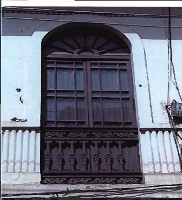
Referencia: BALCONCILLO CON BARANDILLAS METALICAS Y PUERTA CRISTALERA CON ARCO DE MEDIO PUNTO Fotografía: N/A Fecha: N/A
