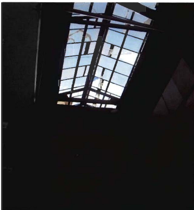
Referencia: CUBIERTA DE METAL Y VIDRIO DEL PATIO INTERIOR Fotografía: PCARVALLO Fecha: 2008-07-17
