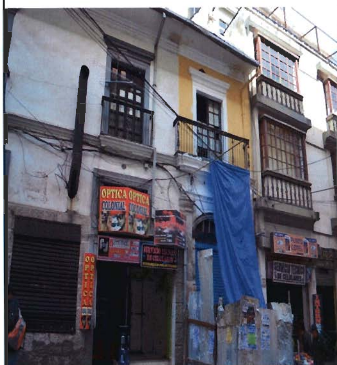
Referencia: FACHADA Fotografía: JBARRIGA Fecha: 2013-06-03
