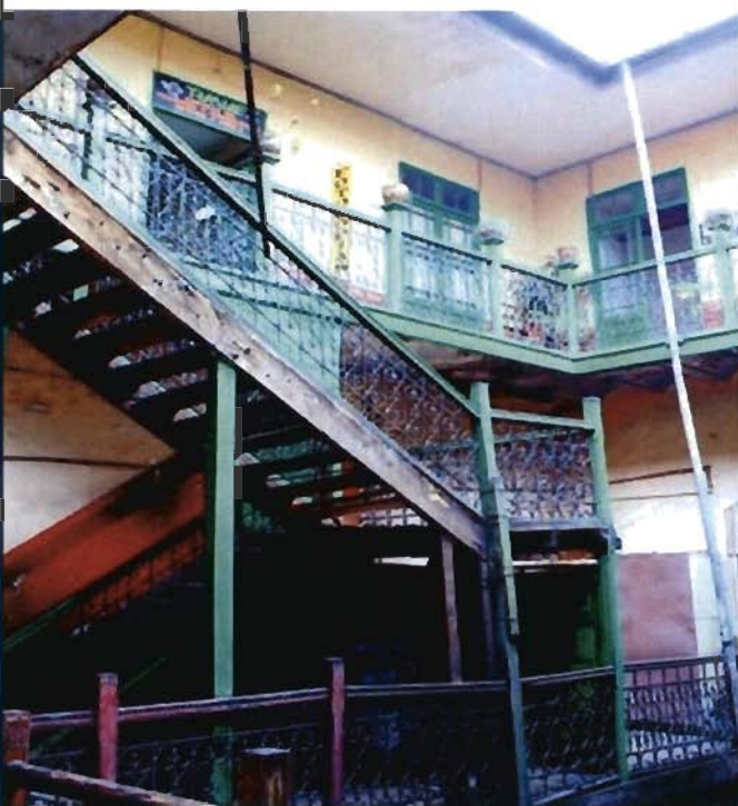
Referencia: VISTA DE LA ESCALERA DE MADERA EN EL PATIO CENTRAL Fotografía: N/A Fecha: N/A
