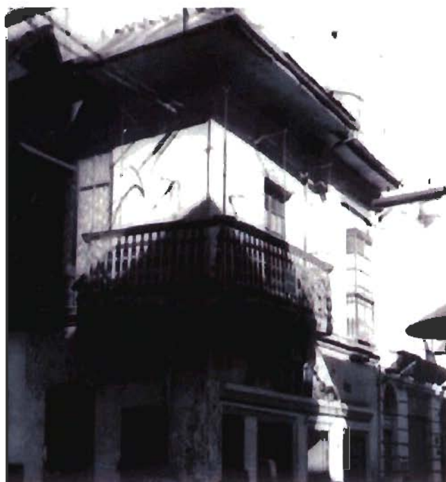
Referencia: BALCON CORRIDO EN ESQUINA - FOTOGRAFIA DE ARCHIVO Fotografía: N/A Fecha: N/A
