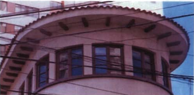
Referencia: VISTA DE LA CUBIERTA DEL VOLUMEN CURVO Fotografía: N/A Fecha: N/A
