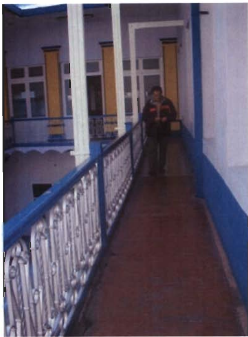
Referencia: CORREDOR EN SEGUNDO NIVEL Fotografía: M.CASTRO Fecha: 2009-03-25
