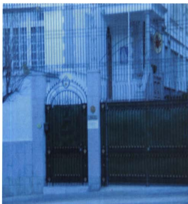
Referencia: PUERTA DE INGRESO TRABAJADA EN METAL Fotografía: MCASTRO Fecha: 2008-05-23
