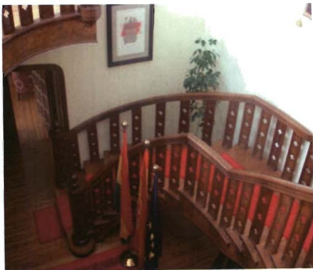
Referencia: VISTA DEL ARRANQUE DE LAS ESCALERAS HELICOIDALES Fotografía: M.CASTRO Fecha: 2009-03-20
