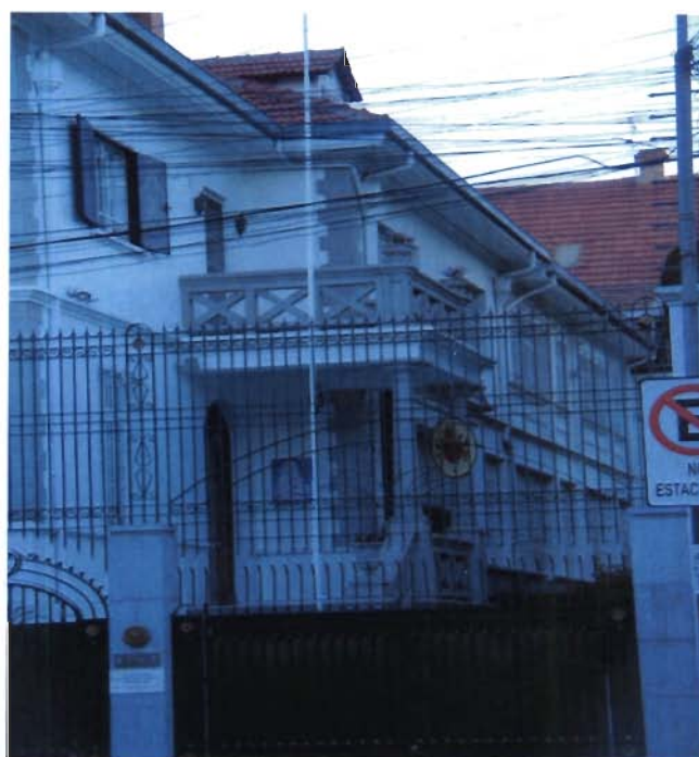
Referencia: BALCON ABIERTO SOBRE COLUMNAS Fotografía: MCASTRO Fecha: 2008-05-23
