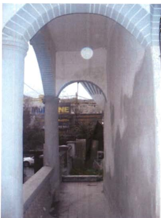
Referencia: GALERIA EN PLANTA BAJA Fotografía: M.CASTRO Fecha: 2009-03-26
