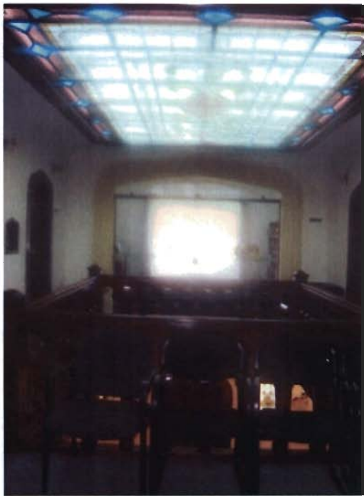
Referencia: VISTA DEL CORREDOR Y DEL VITRAL EN CLARABOYA Fotografía: M.CASTRO Fecha: 2009-03-09
