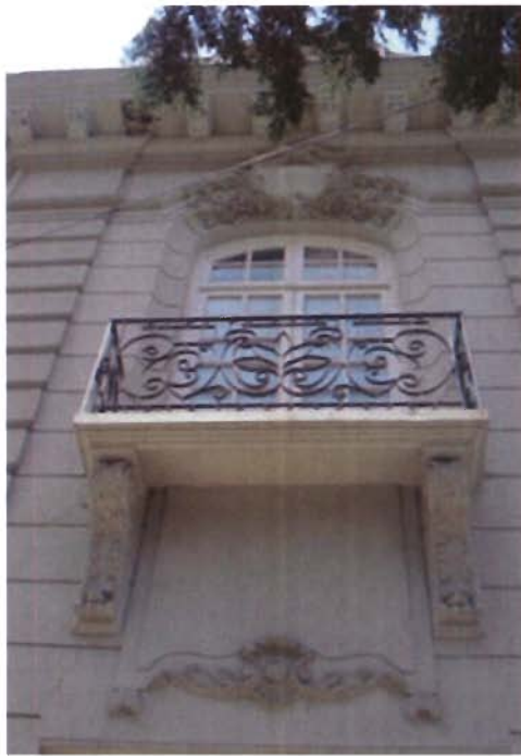
Referencia: BALCON ABIERTO APOYADO SOBRE MENSULAS Fotografía: M.CASTRO Fecha: 2009-03-09
