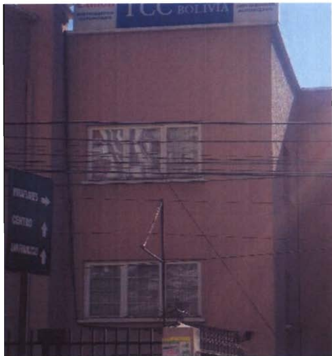
Referencia: DETALLE DEL VOLUMEN LATERAL Fotografía: SIBEI Fecha: 2014-02-07
