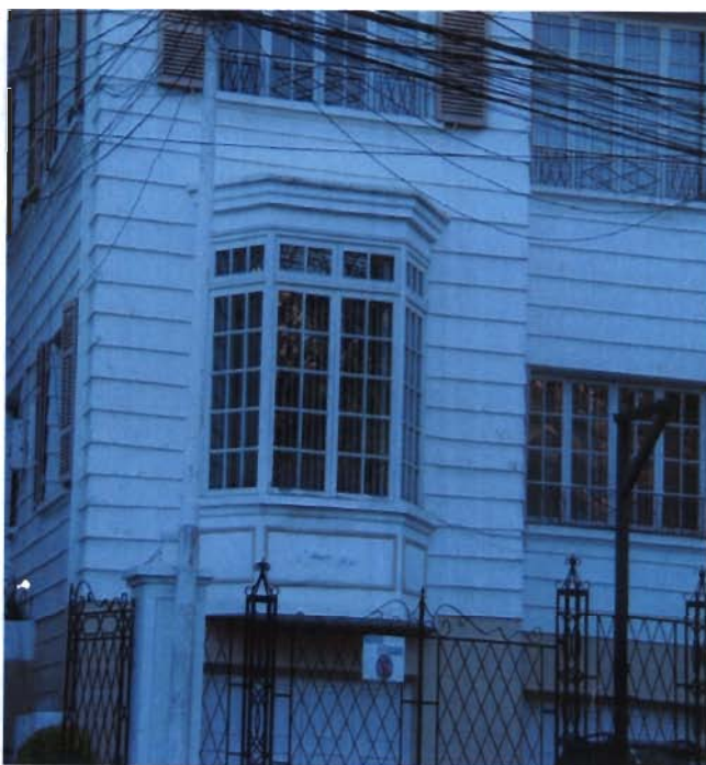
Referencia: BALCON CERRADO TRABAJADO EN MADERA Fotografía: MCASTRO Fecha: 2008-05-23
