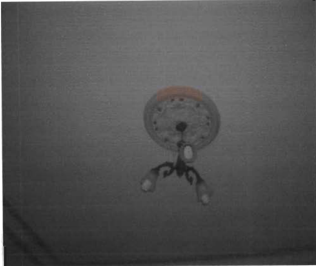
Referencia: DETALLE DE LOS ACABADOS EN CIELOS Fotografía: P.CARVALLO Fecha: 2009-09-08
