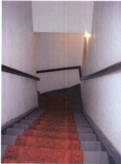
Referencia: DETALLE DE ESCALERAS EN L TRABAJADAS EN MADERA CON REVESTIMIENTO DE ALFONBRA Fotografía: M.CASTRO Fecha: 2009-05-07
