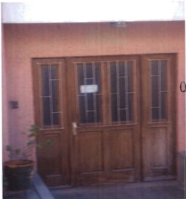
Referencia: VISTA E LA PUERTA DE INGRESO Fotografía: SIBEI Fecha: 2014-02-07
