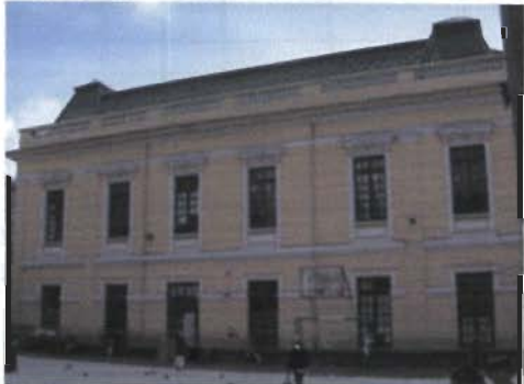
Referencia: FACHADA AV. MONTES - FACHADA CALLE V.J. EGUINO Fotografía: N/A Fecha: N/A
