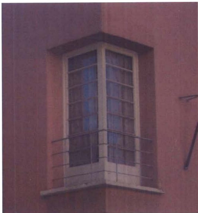
Referencia: DETALLE DE LA CARPINTERIA RESULETA EN ESQUINA Fotografía: SIBEI Fecha: 2014-02-07
