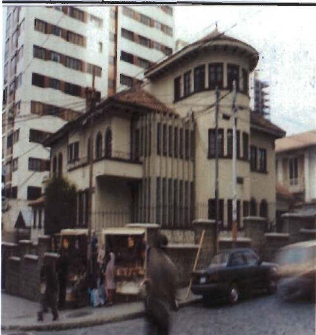
Referencia: FACHADA CALLE PINILLA Fotografía: N/A Fecha: N/A
