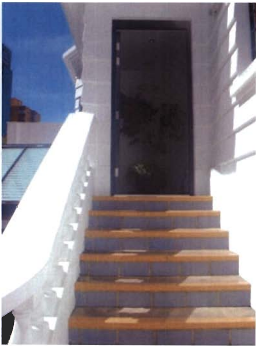
Referencia: DETALLE DE ESCALERAS EXTERIORES Fotografía: M.CASTRO Fecha: 2009-03-30
