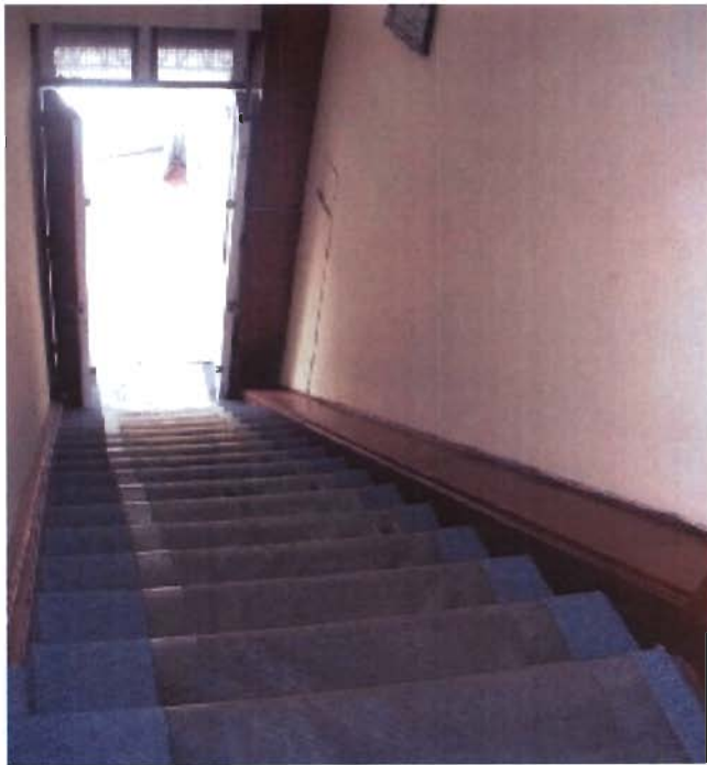
Referencia: ESCALERAS RECTAS DE MADERA QUE CONDUCE AL SEGUNDO NIVEL Fotografía: N/A Fecha: N/A
