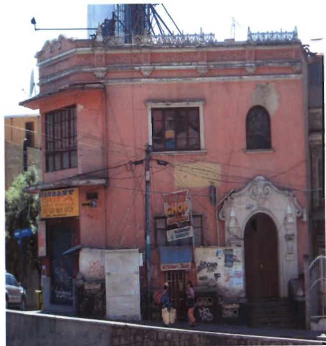
Referencia: FACHADA AV. ARCE Fotografía: O.OGALDE Fecha: 2008-09-07
